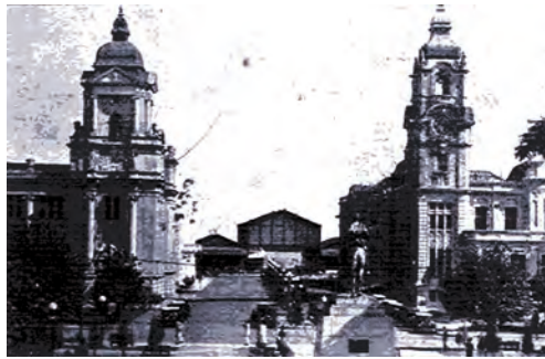
Fig. 10: Vista da Avenida Sepúlveda (Acervo Gedurb).
