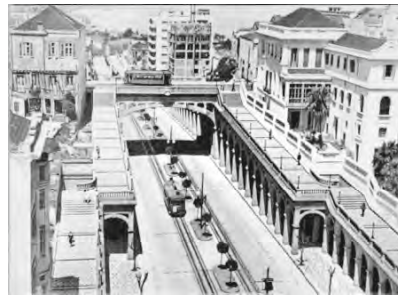
Fig. 14: A Avenida Borges e o Viaduto Otávio Rocha quando de sua inauguração, década de 1930-40.
