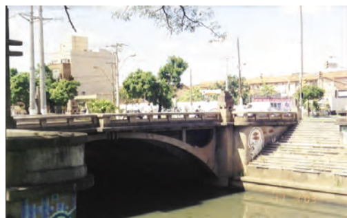
Fig. 23: Imagem atual, canalizado com pontes atravessando seu leito (Acervo Gedurb).
