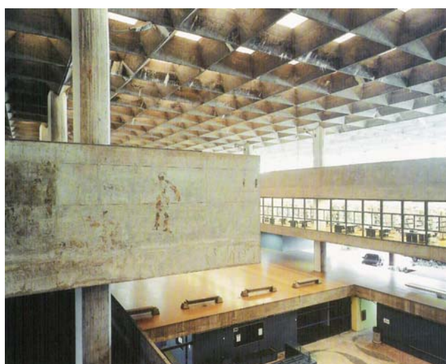
Vista do volume do ateliê interdepartamental em balanço sobre o salão caramelo e entrada do auditório em nível inferior.
