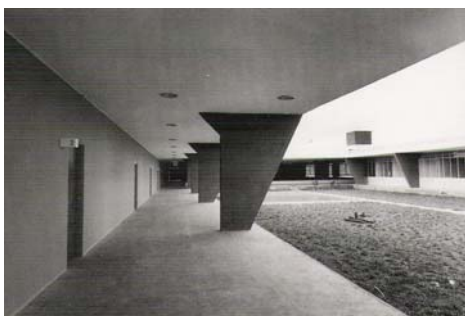
Corredor das salas de aula e jardim
