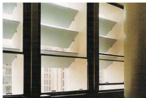
Detalhe dos brises na face norte.
