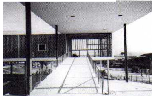
Vista da rampa de entrada
