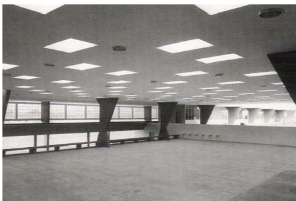
Pátio coberto do Ginásio de Guarulhos com jardim ao fundo.
