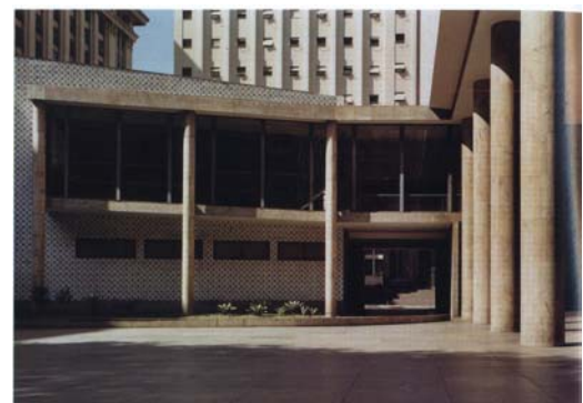
Acesso à rua da Imprensa e volume do auditório
