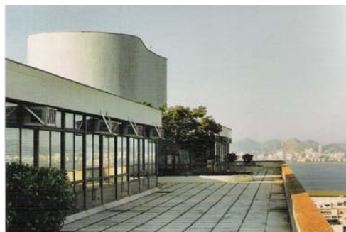
Cobertura do edifício.
