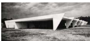
Vilanova Artigas Ginásio de Itanhaém, SP 1959
