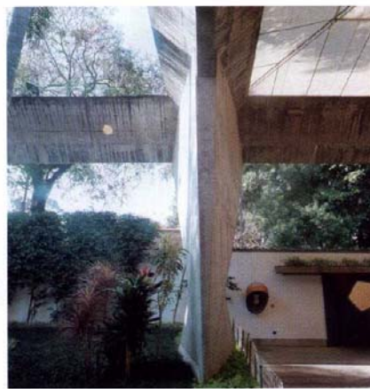
Detalhe da estrutura
