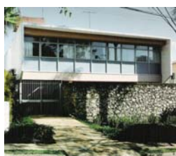
Vilanova Artigas e Carlos Cascaldi Fachada 2ª resid Taques Bittencourt, São Paulo, 1956.
