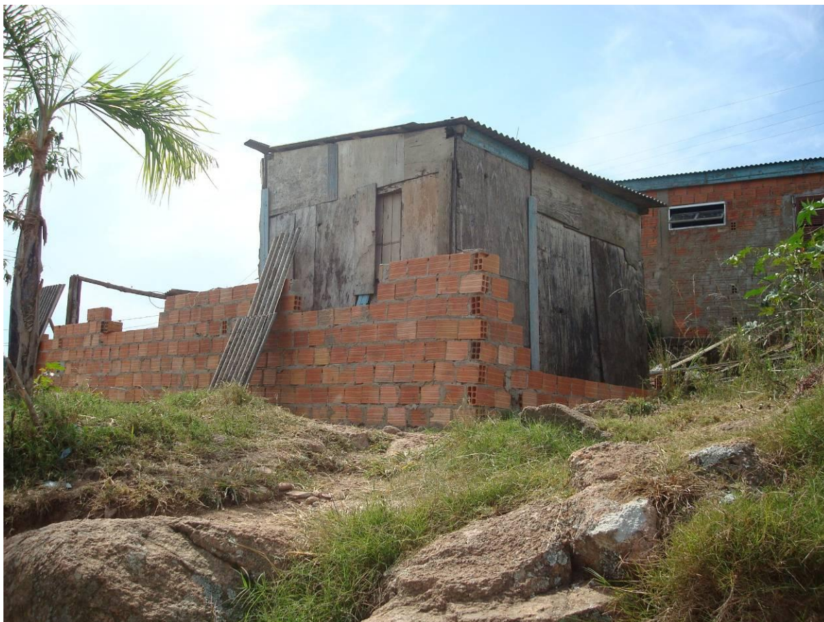
Foto 23: Casa em construção.
