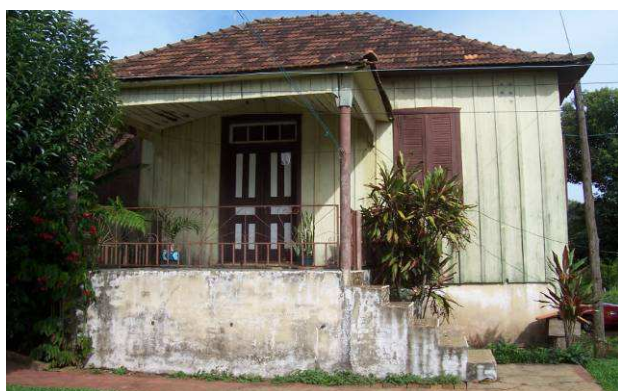
Figura 8: Unidade habitacional reformada em parceria com a COOPERHAF
