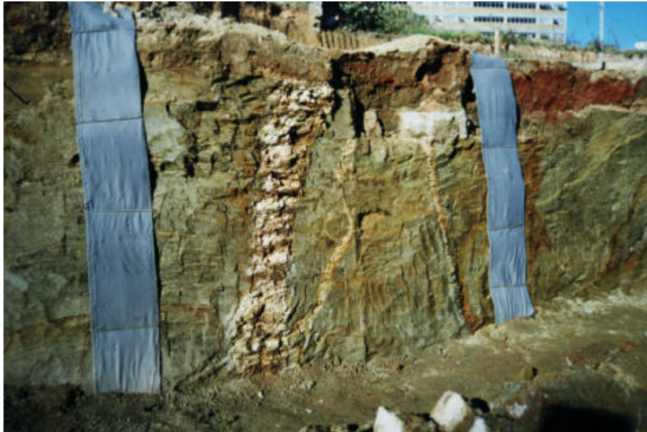
Figura 3-2: Vista de um perfil da escavação, mostrando o solo residual de gnaiss cortado por um veio de pegmatito.
