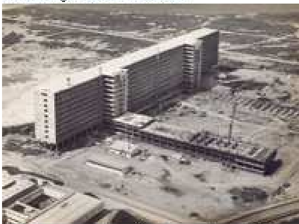
HU em construção. Projeto inicial previa 2000 leitos.
