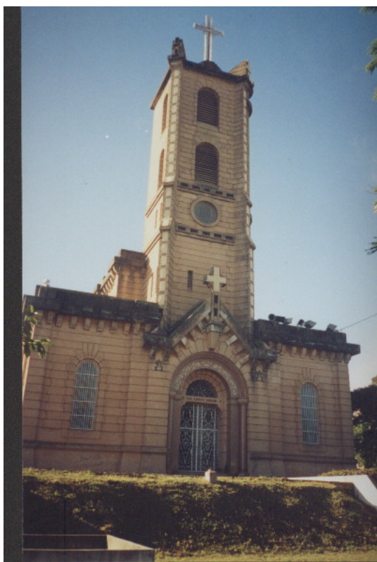
Fig 5: Vista frontal Igreja Santo Antônio
