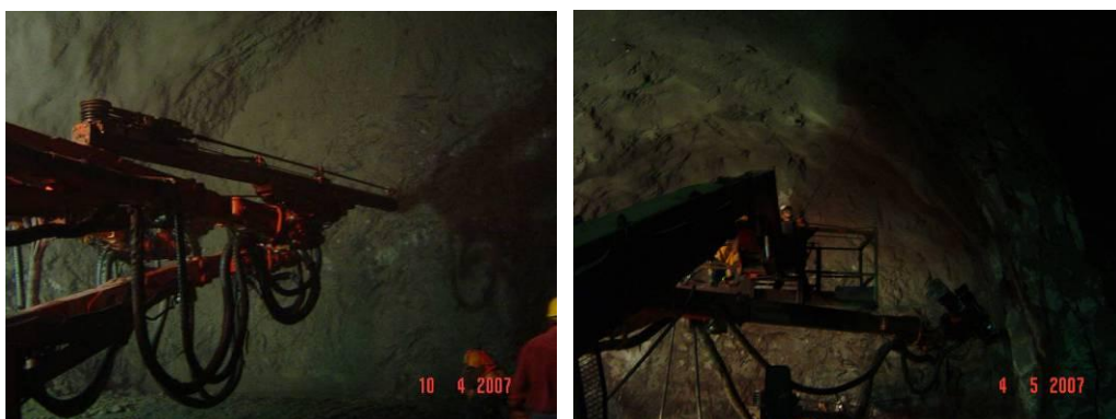
Figura 5-11: a esquerda perfuração da frente, a direita instalação dos chumbadores durante a perfuração da frente.
