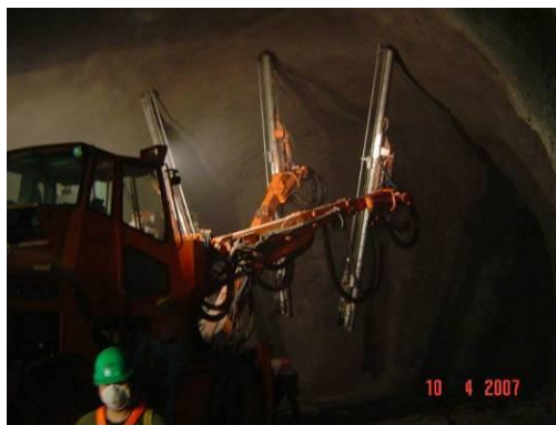
Figura 5-10: perfuração para colocação dos chumbadores.
