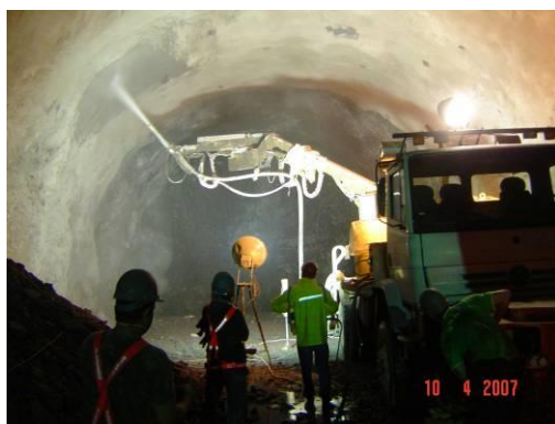
Figura 5-14: aplicação do concreto projetado.
