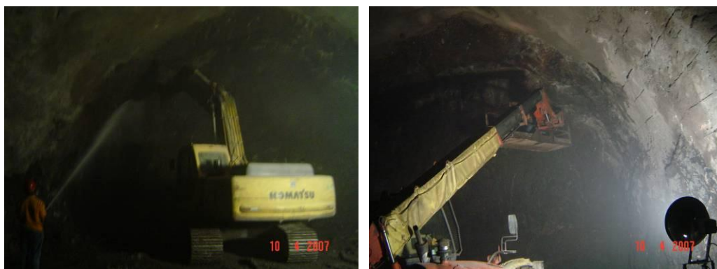
Figura 5-13: a esquerda bate-choco mecânico, a direita bate-choco manual.
