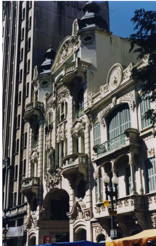
Figura 6 - Antigos Cine Guarani (ao centro), obra de Theo Wiederspahn (1914), e Farmácia Carvalho (à direita). As duas fachadas estão preservadas, mas, atrás, o resto dos edifícios antigos foi demolido, sendo construída estrutura totalmente nova para uso do Banco Safra. À esquerda, aparece parte do Edifício Imperial. Fotografia do autor.
