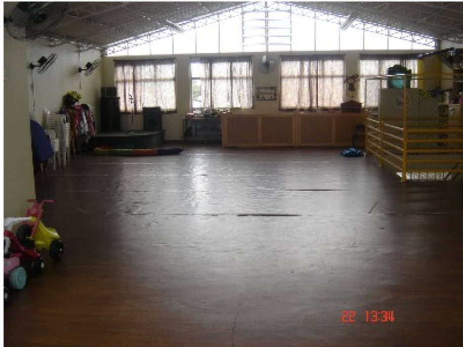
Figura 03 - Terceiro piso da escola
