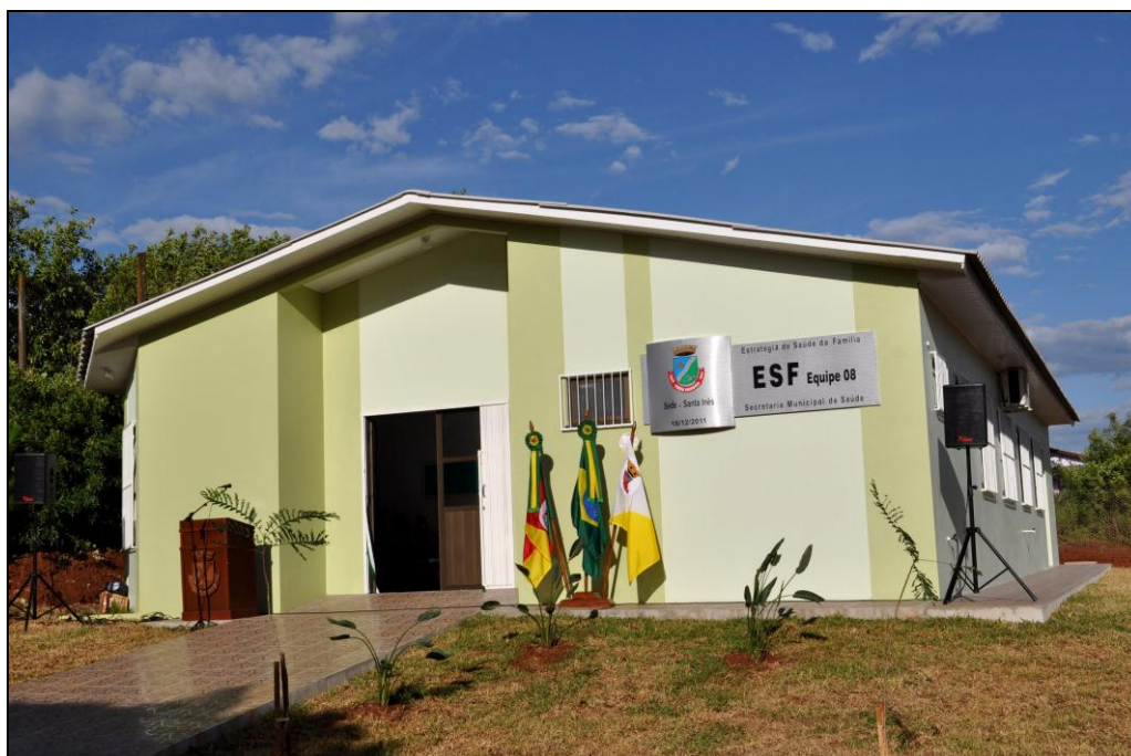
Foto Unidade de ESF da Santa Inês (construção)
