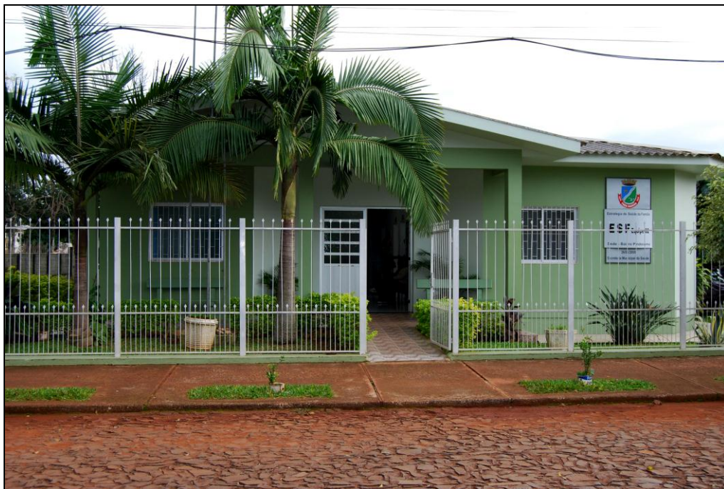
Foto Unidade de ESF da Pindorama (reforma)
