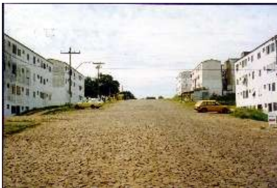
Figura 6: Av. Tupy Silveira – com pavimentação – Núcleo Ney Azambuja
