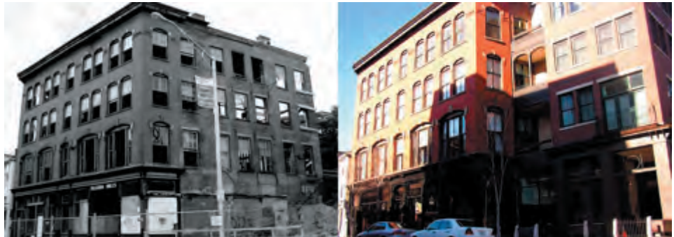
101 North Main St. [anexo 43] antes e depois (2000) Providence/RI
