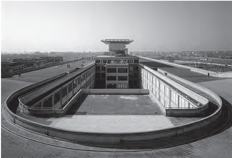
15 Fábrica Fiat Lingotto Vista da cobertura
