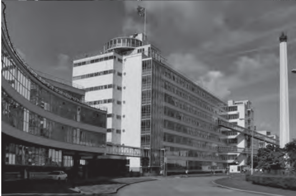
24 Fábrica Van Nelle Vista geral
