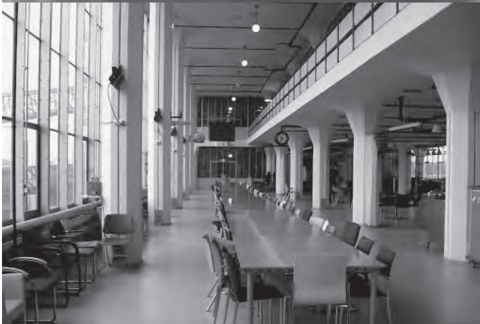
28 Fábrica Van Nelle Vista interna após reabilitação
