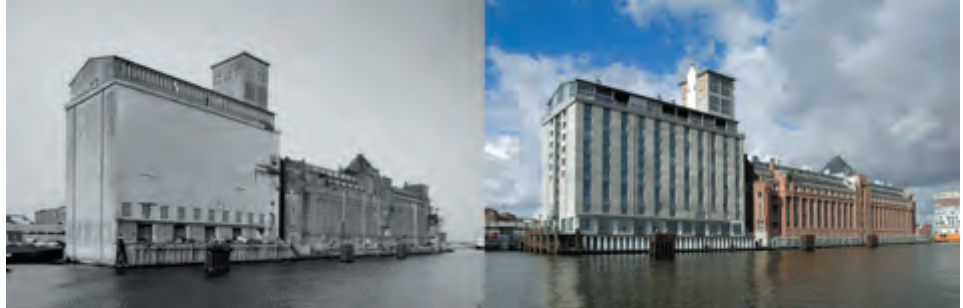
Graansilo [anexo 62] antes (1896) e depois (1997) Amsterdam, Holanda
