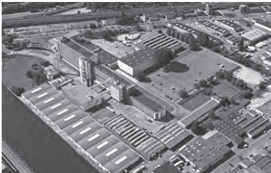
22 Fábrica Van Nelle Vista aérea
