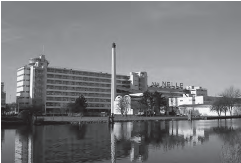
23 Fábrica Van Nelle Vista desde o rio
