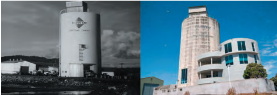
Silos at Raglan [anexo 86] antes (1964) e depois Raglan, Nova Zelândia
