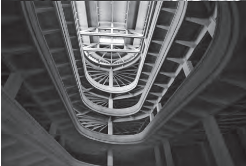
20 Fábrica Fiat Lingotto Rampa helicoidal
