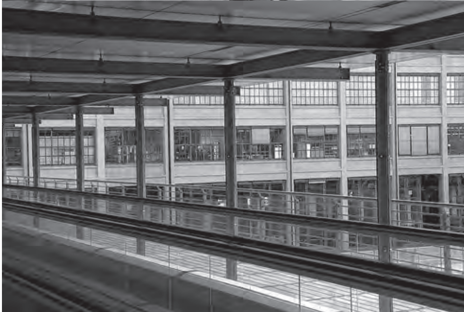
19 Fábrica Fiat Lingotto Vista pátio interno
