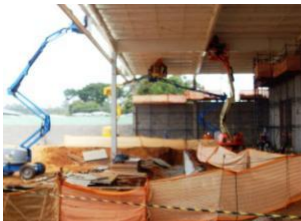
Figura 27 – Divisória plastificada isolando ambiente de produção na obra B
