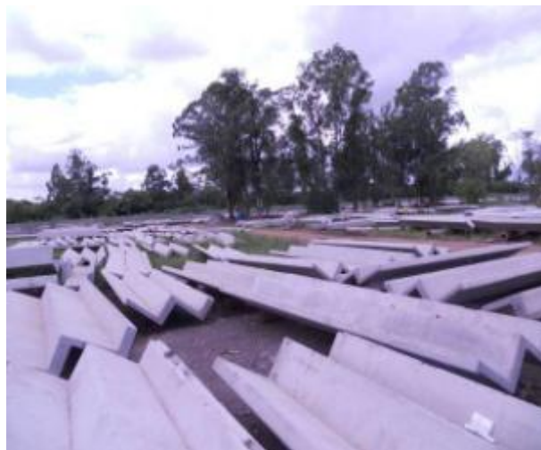
Figura 43 – Estoque das arquibancadas pré-fabricadas localizadas na parte externa à construção A
