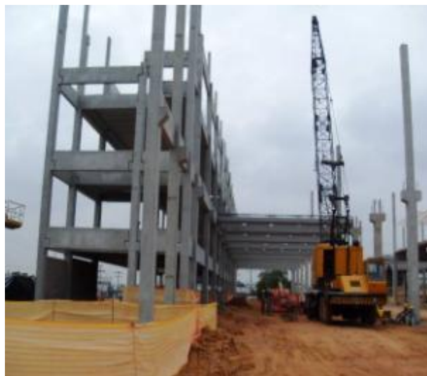
Figura 59 – Montagem da estrutura pré-moldada da obra B
