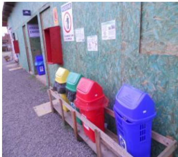
Figura 45 – Lixeiras padronizadas na obra B
