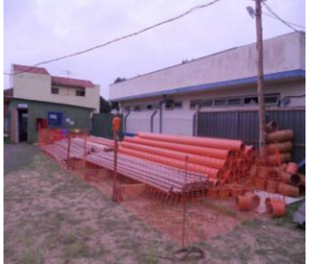
Figura 47 – Estoque de tubulações isoladas por cerca plastificada, no canteiro B
