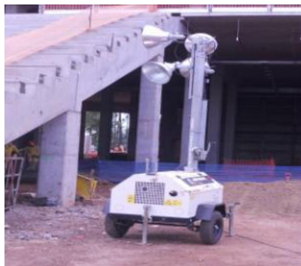
Figura 70 – Detalhe do refletor móvel provisório utilizado na obra A
