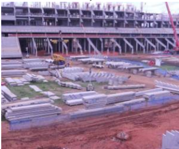
Figura 42 – Armazenamento de elementos construtivos pré-moldados em local centralizado à construção A
