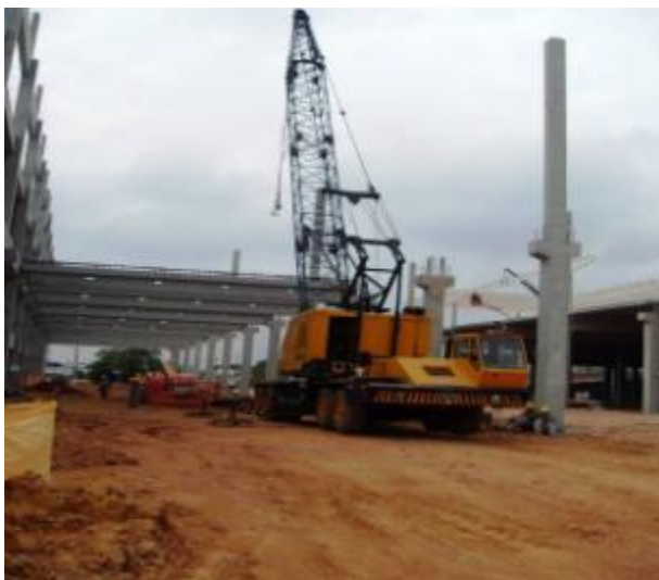
Figura 58 – Equipamento para elevação e montagem de elementos pré-moldados da obra B
