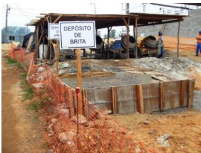
Figura 41 – Depósito de areia e brita na obra B
