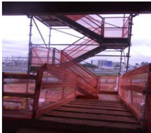
Figura 33 – Delimitação lateral da escadaria provisória na obra A
