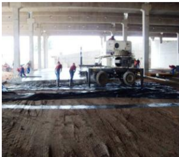
Figura 60 – Detalhe do regularizador de pisos utilizado na obra B
