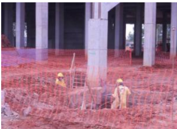
Figura 26 – Cerca plastificada vazada, permitindo total visualização dos ambientes e das atividades na obra A
