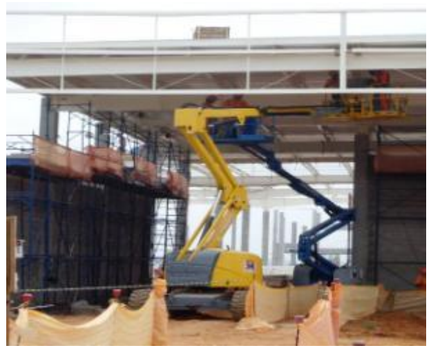
Figura 57 – Detalhe do cesto aéreo utilizado na obra B
