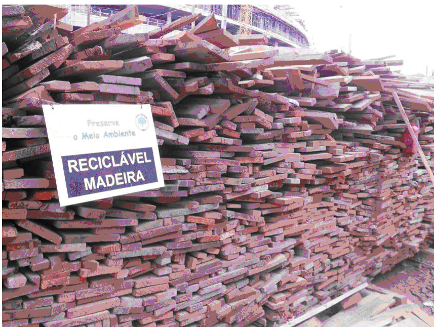
Figura 15 – Estoque de madeira usada destinada à reciclagem no canteiro A
