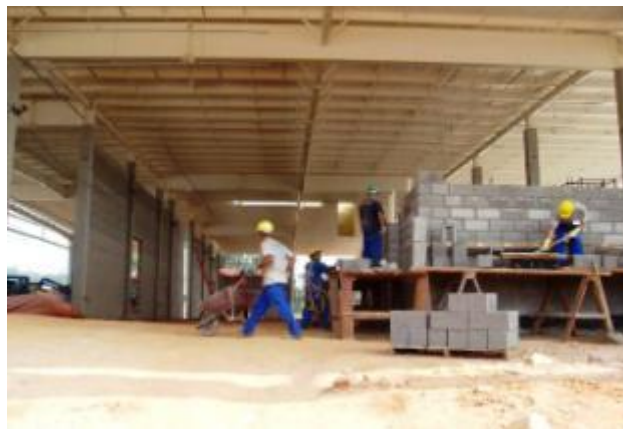
Figura 66 – Local de trabalho amplo, arejado e bem iluminado no canteiro B
