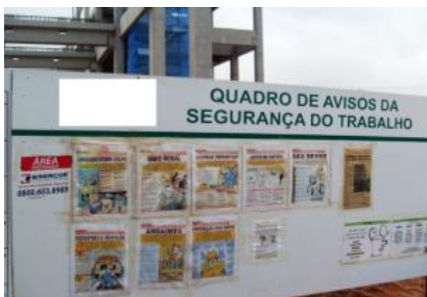
Figura 83 – Detalhe do quadro de avisos da segurança do trabalho no canteiro B
