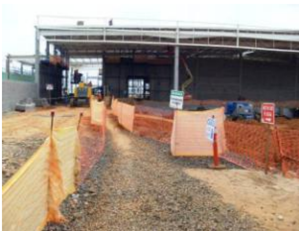
Figura 34 – Cercas plásticas especificando o caminho de pedestres no canteiro B
