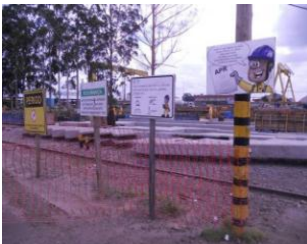
Figura 98 – Disponibilização de diversos indicadores visuais na entrada do canteiro A
