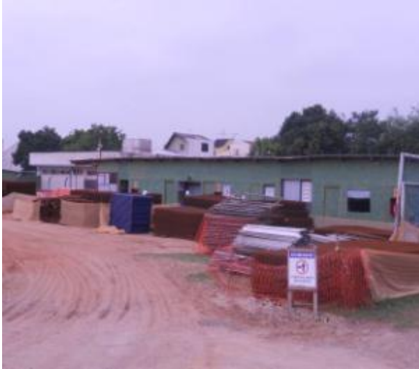
Figura 46 – Terreno destinado exclusivamente ao armazenamento de materiais e elementos construtivos na obra B
