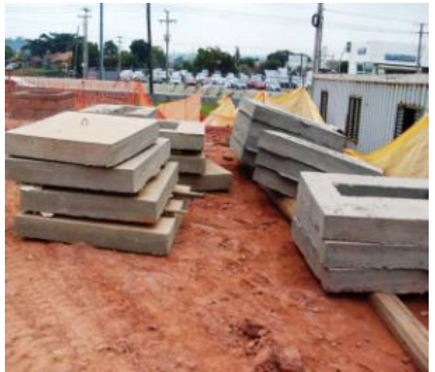
Figura 49 – Estoque de elementos pré-moldados de forma aleatória no canteiro B
