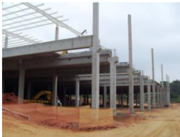
Figura 25 – Divisória plastificada delimitando ambiente interno e externo de produção da obra B
