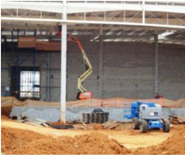
Figura 56 – Equipamento destinado à elevação de operários para realização de manutenções e montagens na obra B
