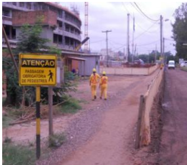
Figura 31 – Padronização do caminho de pedestres no canteiro A
