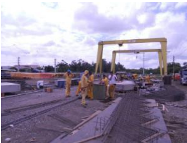
Figura 54 – Operários trabalhando com auxílio do pórtico, no canteiro A
