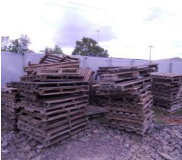
Figura 62 – Estoque de páletes no canteiro B
