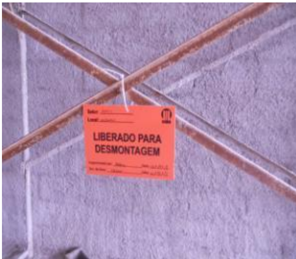
Figura 90 – Indicação visual de estrutura metálica provisória liberada para desmontagem no canteiro A
