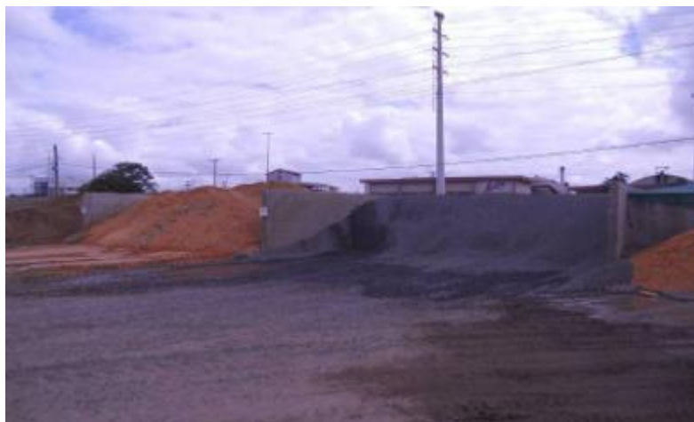
Figura 40 – Baias de armazenamento dos agregados na obra A
