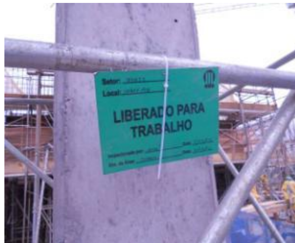
Figura 89 – Indicação visual de estrutura liberada para trabalho no canteiro A
