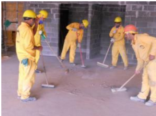
Figura 13 – Realização de atividades periódicas de limpeza e manutenção na obra A
