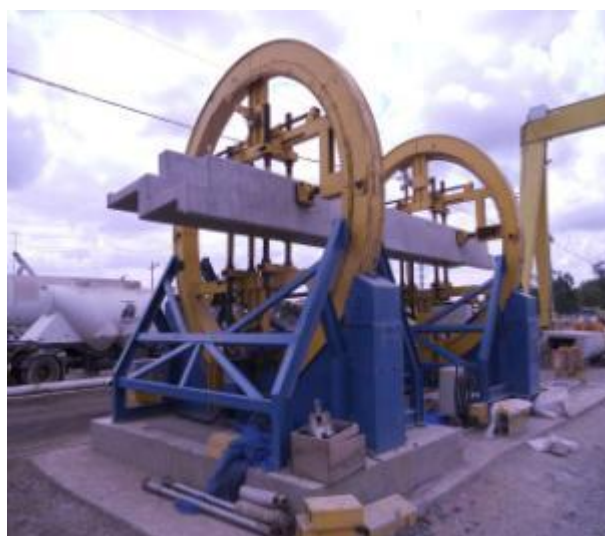
Figura 51 – Vista lateral do girador utilizado na obra A
