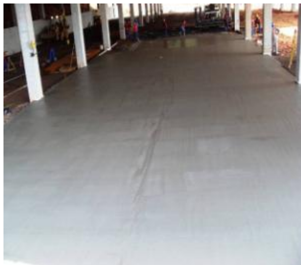
Figura 61 – Superfície regularizada pelo equipamento utilizado na obra B
