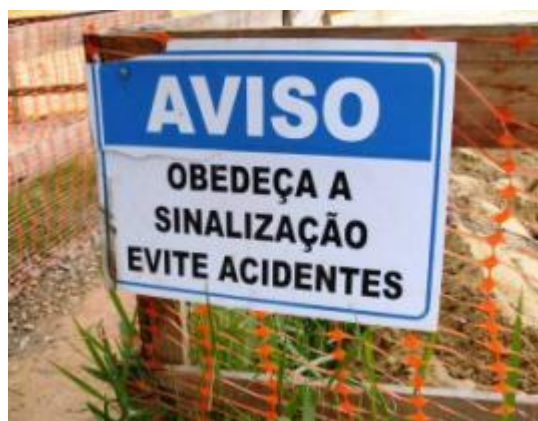
Figura 84 – Aviso quanto à necessidade das sinalizações serem obedecidas no canteiro B
