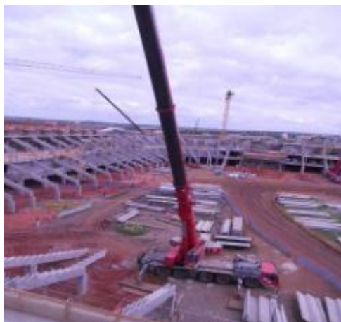
Figura 52 – Guindaste na obra A
