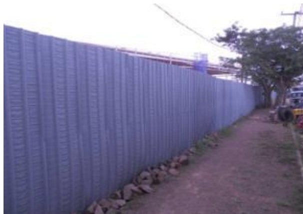
Figura 74 – Detalhe do tapume ecológico utilizado na obra B
