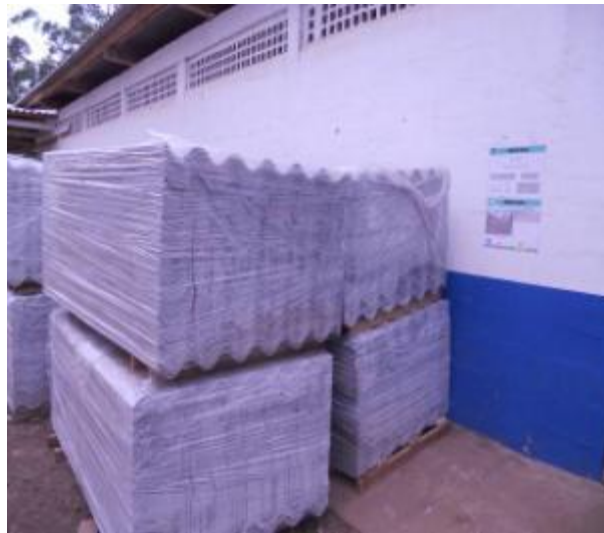
Figura 63 – Detalhe do estoque de telhas posicionadas sobre páletes no canteiro A
