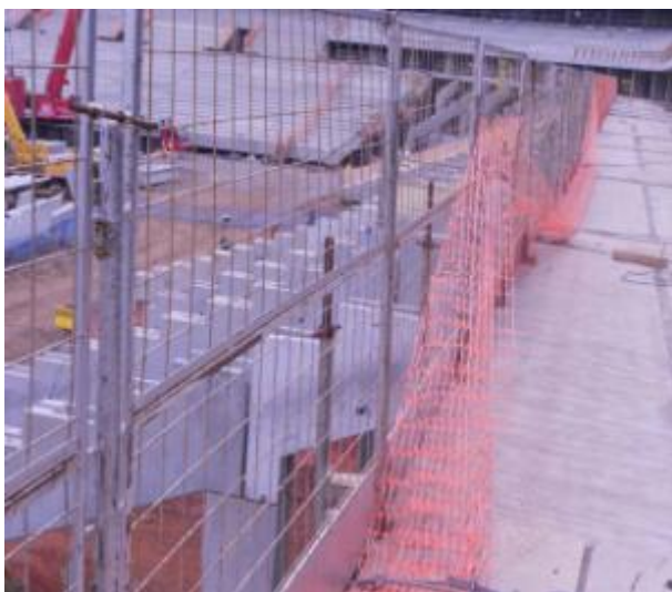
Figura 22 – Cerca metálica delimitando o ambiente interno e externo da construção A
