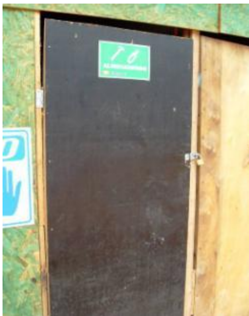
Figura 39 – Porta de entrada do almoxarifado da obra B
