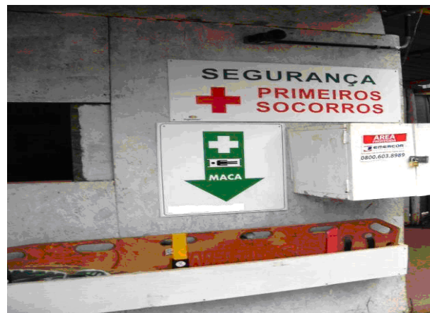
Figura 95 – Indicação da posição dos materiais e equipamentos de segurança da obra B
