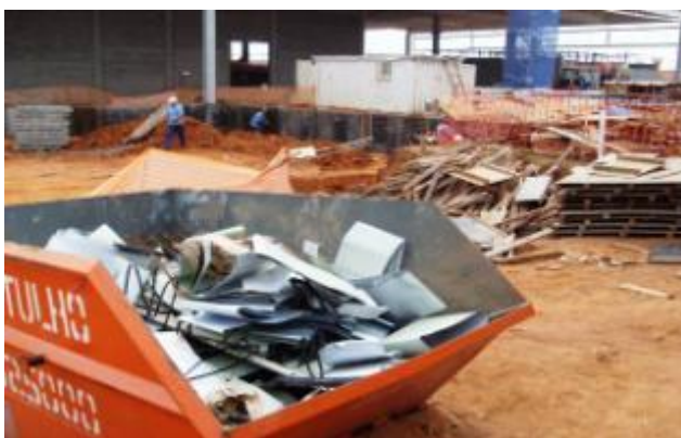
Figura 16 – Ambiente externo desorganizado e com quantidade insuficiente de contêineres coletores no canteiro B
