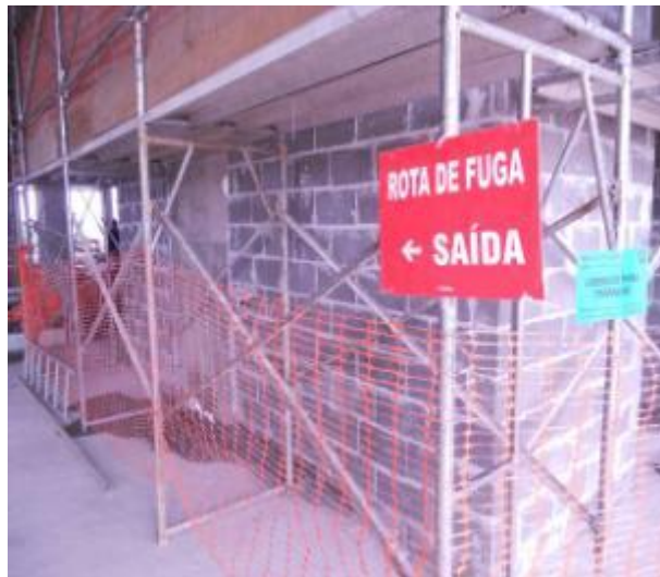
Figura 91 – Indicação visual da rota de fuga na obra A
