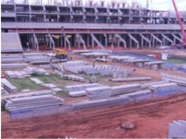
Figura 11 – Ambiente externo ao canteiro A organizado e bem distribuído fisicamente
