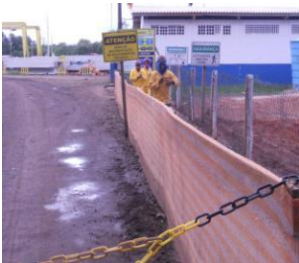
Figura 30 – Delimitação de caminhos de máquinas e pedestres no canteiro A
