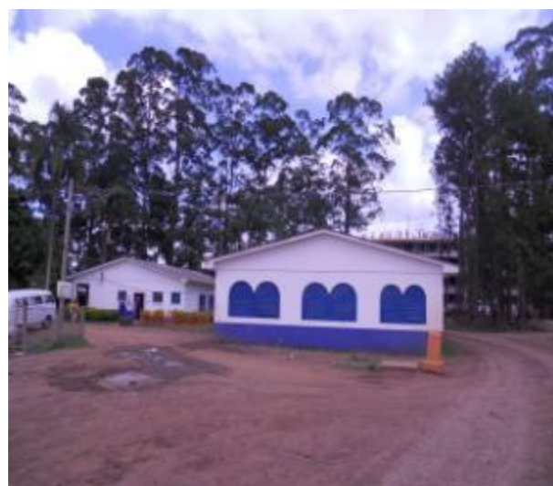
Figura 38 – Localização do almoxarifado da obra A e, ao fundo, a construção do estádio
