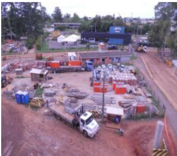
Figura 32 – Imagem aérea do layout externo do canteiro A
