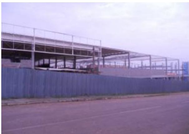
Figura 73 – Tapume principal sem qualquer indicação da empresa B ou do empreendimento
