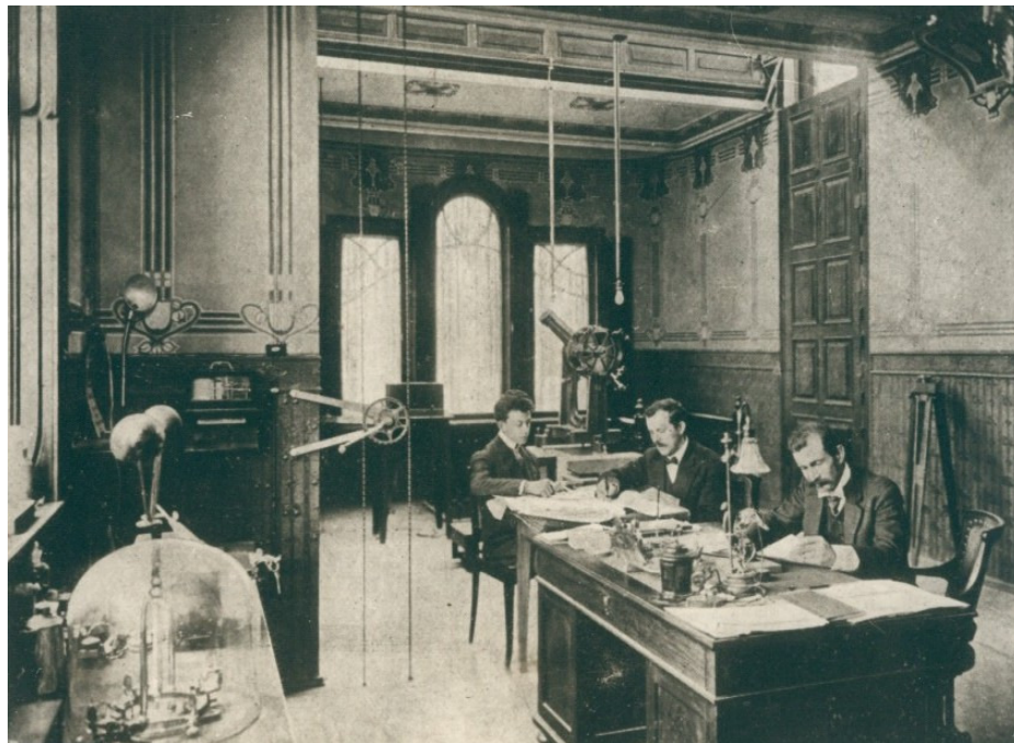
Figura 11 – Fotografia antiga do terceiro pavimento do prédio do Observatório Astronômico
