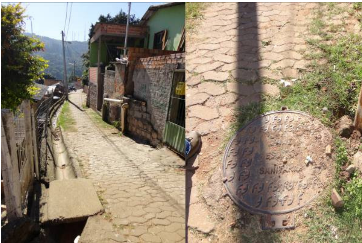
Figura 23 – Sistema de drenagem pluvial e cloacal
