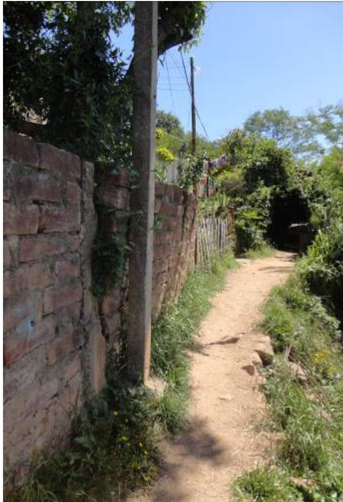
Figura 28 – Acessos com largura insuficiente
