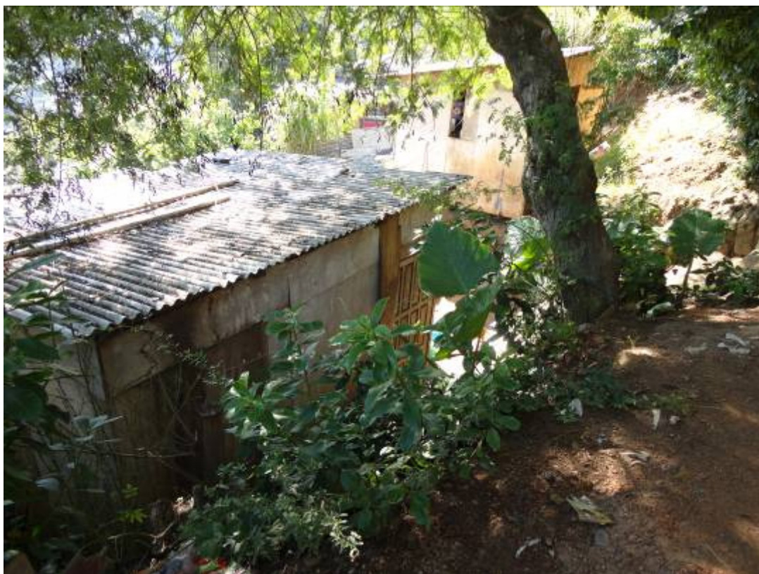
Figura 27 – Taludes inclinados com alturas de 3,00m
