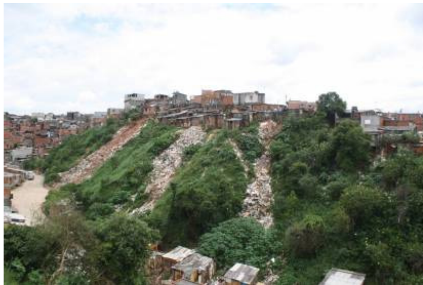
Figura 11 – Despejo de lixo em encostas
