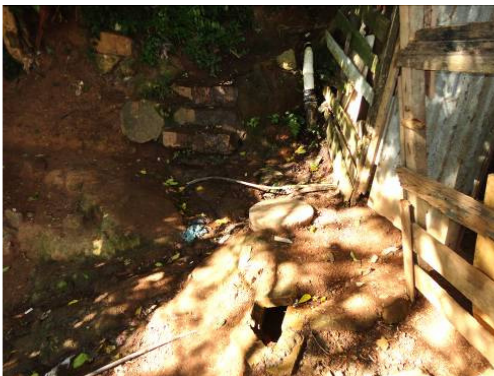
Figura 29 – Drenagem rompida
