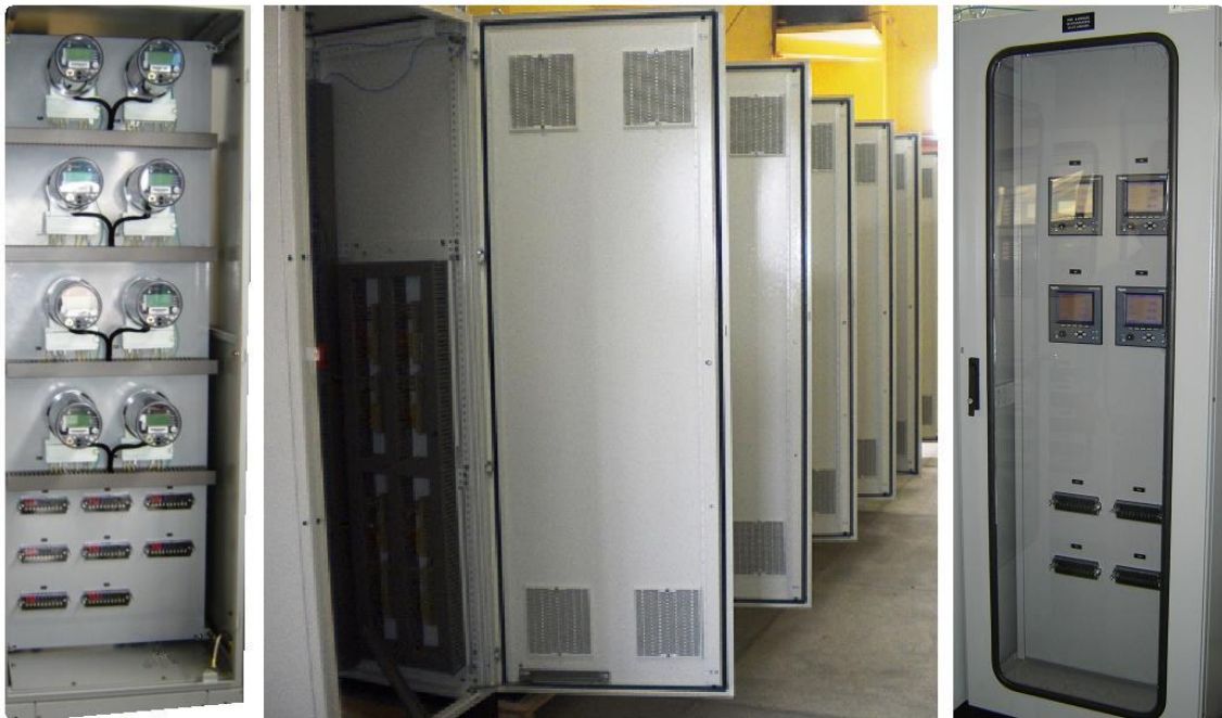
Figura 7 - Painel ou cubículo de medição
