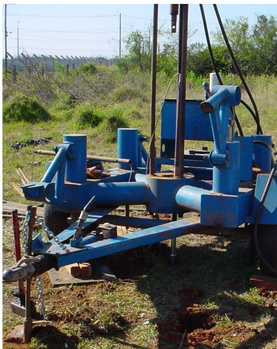
Figura 36: Reboque com sistema hidráulico de cravação
