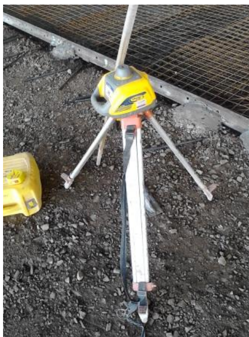
Figura 21 – Utilização do nível a laser para nivelamento das fôrmas
