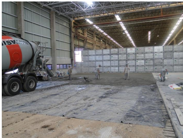
Figura 24 – Lançamento do concreto na obra A
