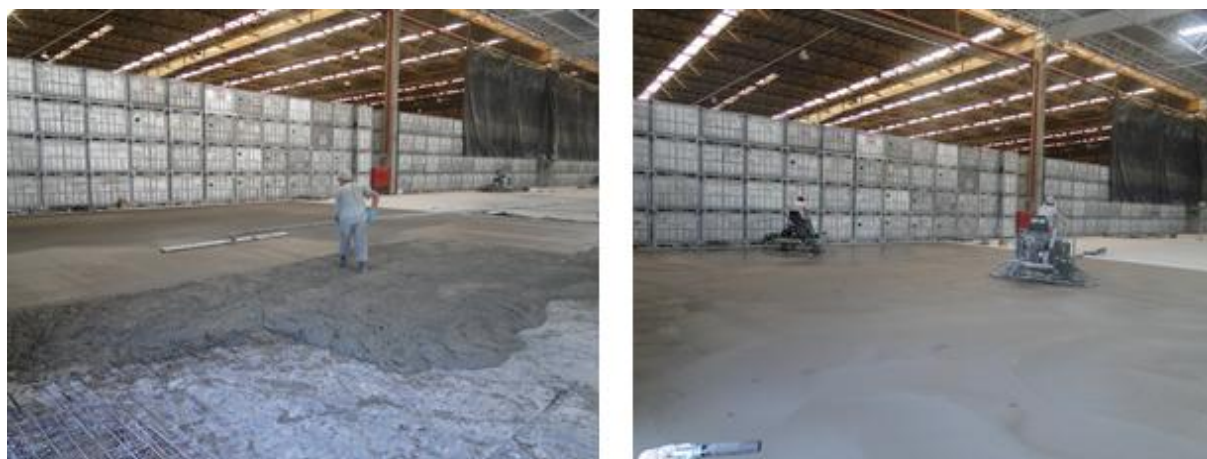
Figura 26 – Utilização do rodo de corte e das acabadoras duplas na obra A
