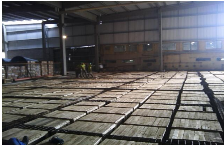
Figura 29 – Estrutura do piso estaqueado da obra D
