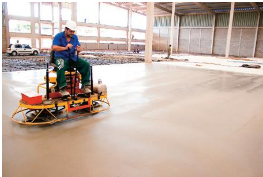
Figura 10 – Desempenho e acabamento mecânico com acabadoras duplas
