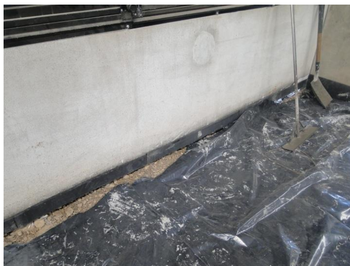
Figura 32 – Utilização de borracha como material isolante nas juntas de encontro
