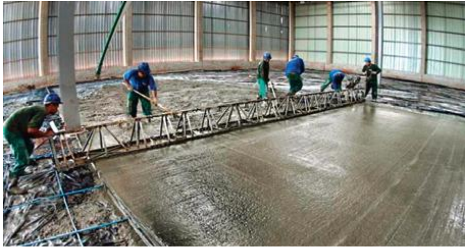
Figura 9 – Espalhamento e adensamento do concreto com régua vibratória
