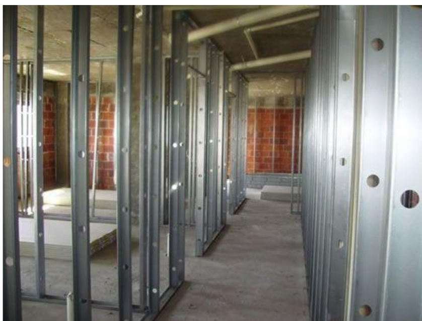
Figura 4 – Estrutura metálica da parede de gesso acartonado
