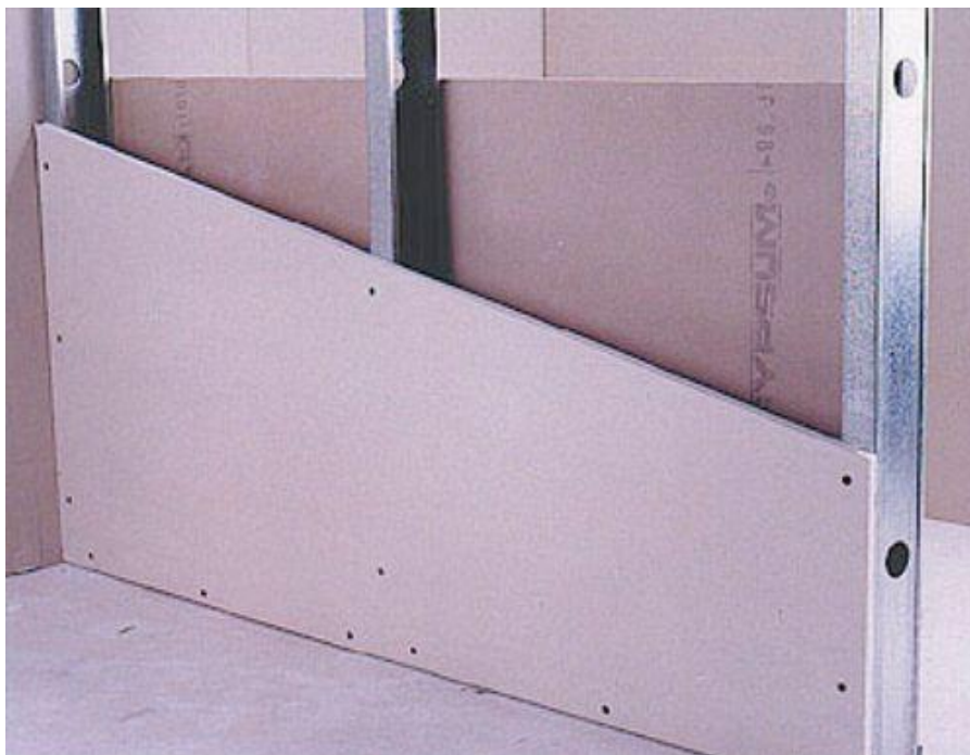
Figura 5 – Colocação da chapa de gesso acartonado
