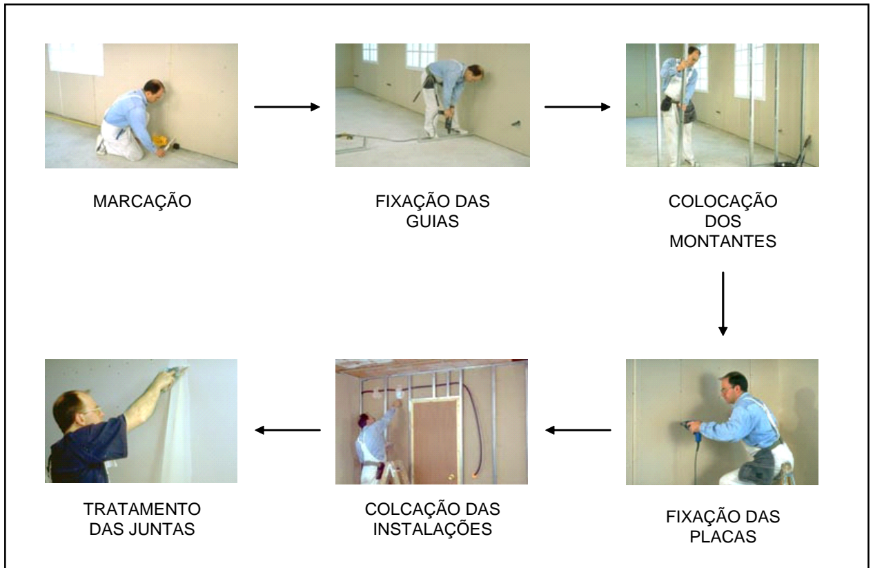
Figura 7 - Etapas na execução de divisórias de gesso acartonado
