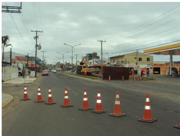
Figura 23 – Sinalização da obra de Torres
