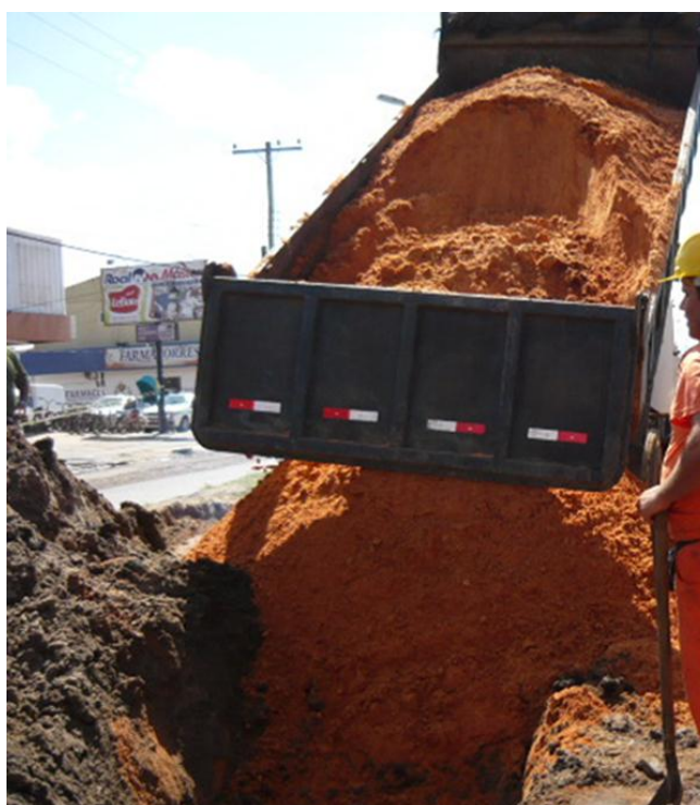
Figura 22 – Fornecimento de material de empréstimo
