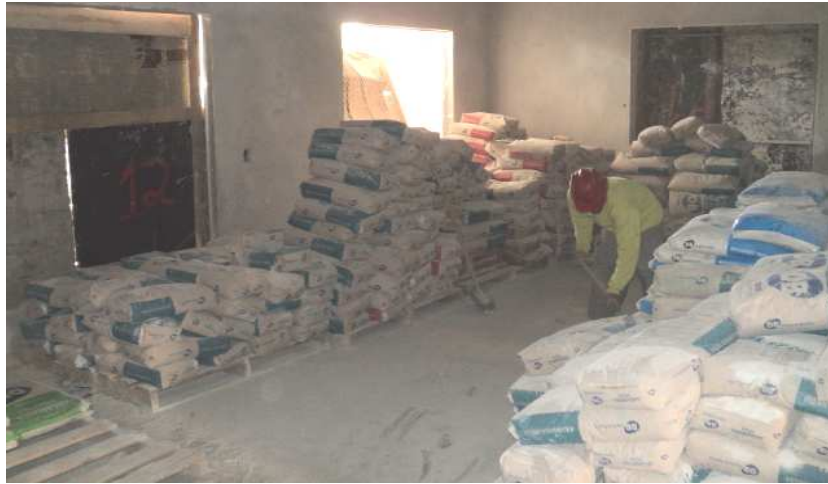
Figura 18 – Depósito de argamassa ensacada no pavimento térreo
