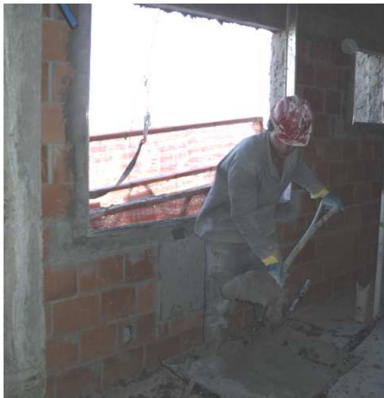
Figura 10 – Abastecimento tradicional de argamassa para revestimento
