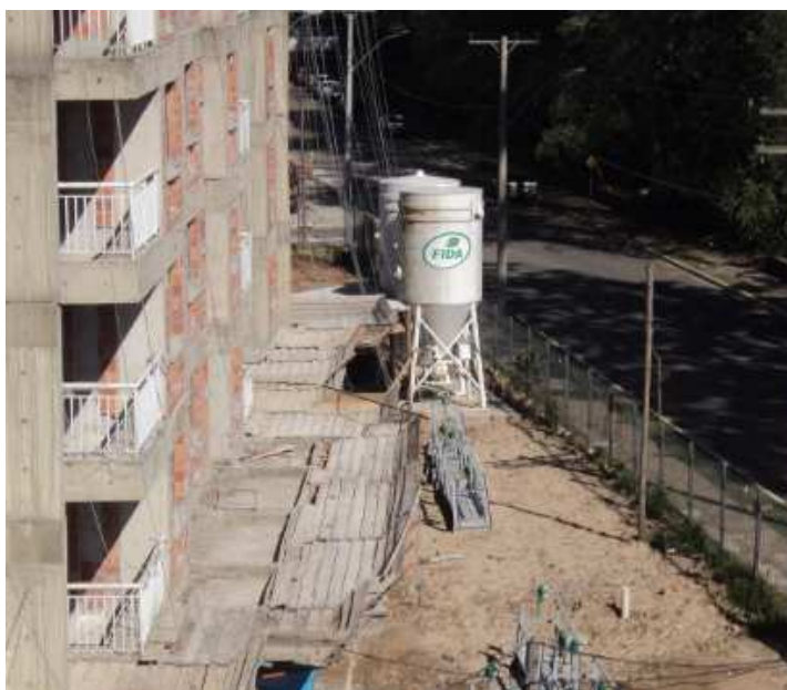
Figura 14 – Posicionamento dos silos dentro do canteiro de obra
