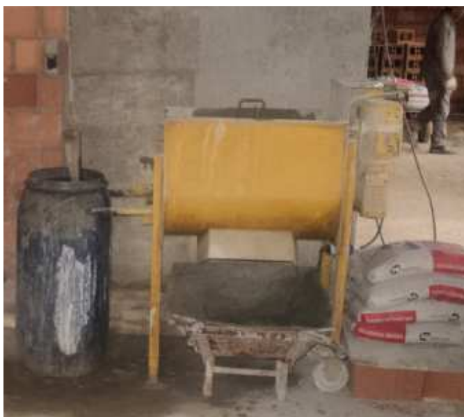
Figura 7 – Argamassadeira para preparo de argamassa no pavimento
