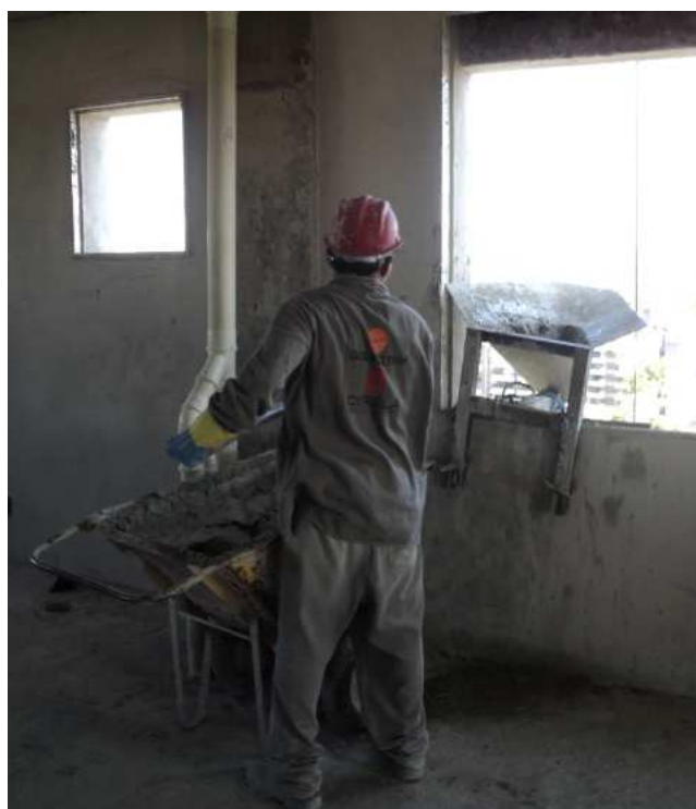
Figura 12 – Funil fixado na janela a uma altura de aproximadamente 1 m
