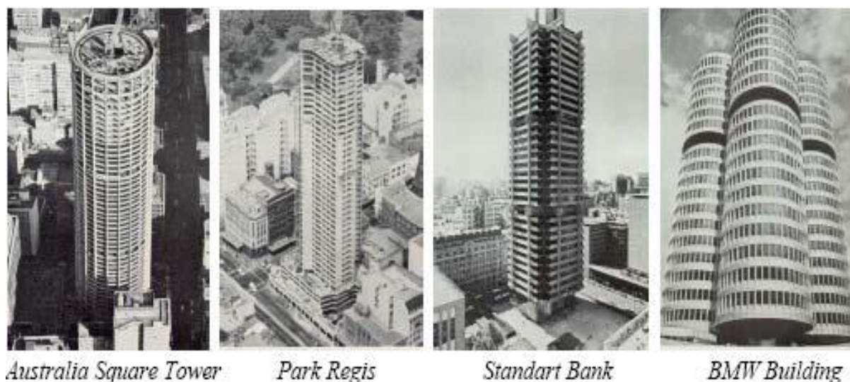
Figura 10 – Edifícios de múltiplos pavimentos executados em concreto leve
