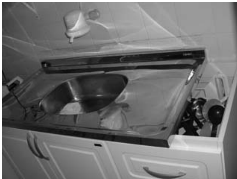
Figura 103: exemplo de tampo do balcão que não foi trocado, 10 cm menor que o móvel pronto adquirido pelo arrendatário
