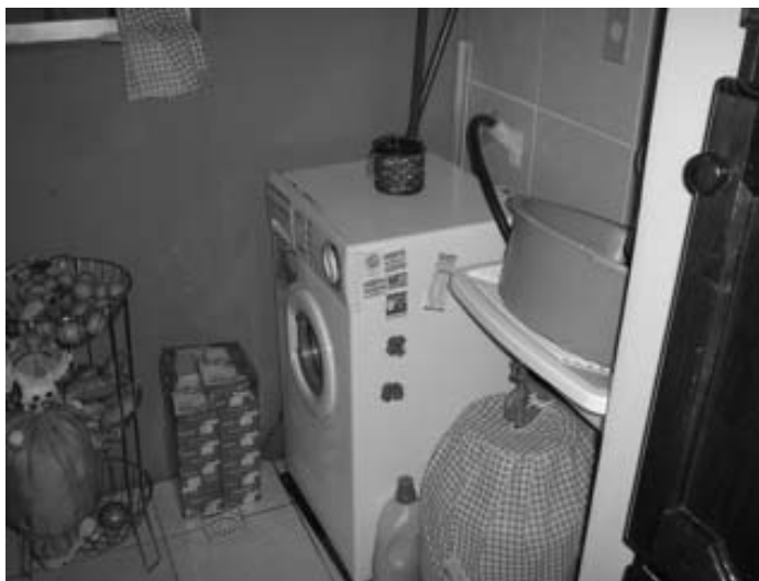
Figura 62: área de serviço do empreendimento A
