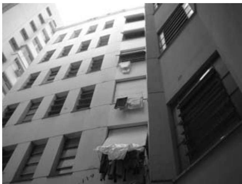
Figura 95: vista dos fundos do edifício, mostrando a janela basculante da cozinha, que impede a colocação de gaita e roupas estendidas nas janelas dos dormitórios
