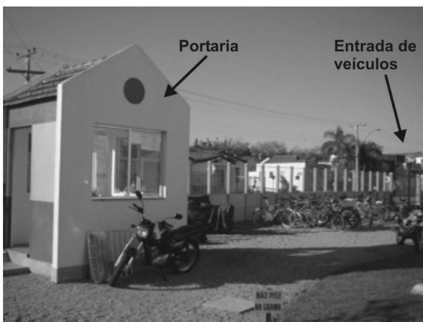
Figura 70: guarita longe da entrada de veículos e tela
