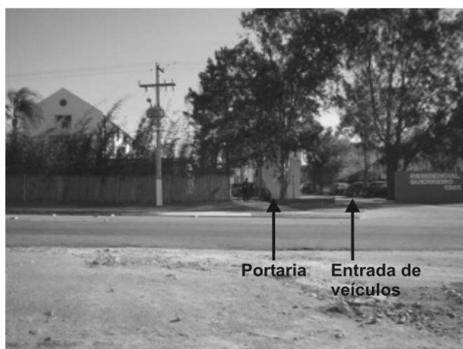
Figura 64: entrada principal do empreendimento H, com guarita ao lado do portão de veículos
