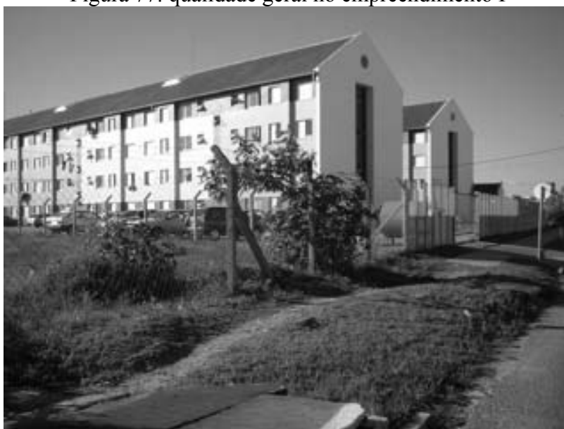
Figura 78: cercamento do empreendimento I
