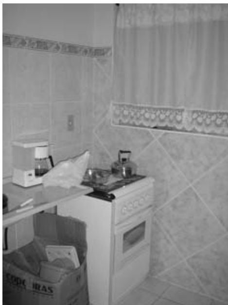
Figura 87: exemplo complemento de acabamento no empreendimento A, utilizando cerâmica na parede da janela
