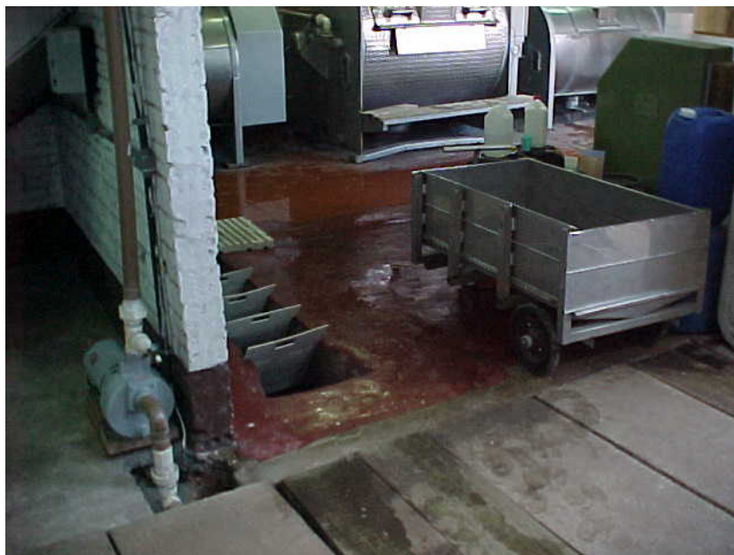
Figura 8. Máquinas de lavar roupas, gradeamento e tanque de equalização.
