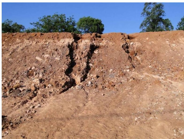
Figura 4.5. Vista frontal de um aterro com problemas de ravinamento e sulcos.
