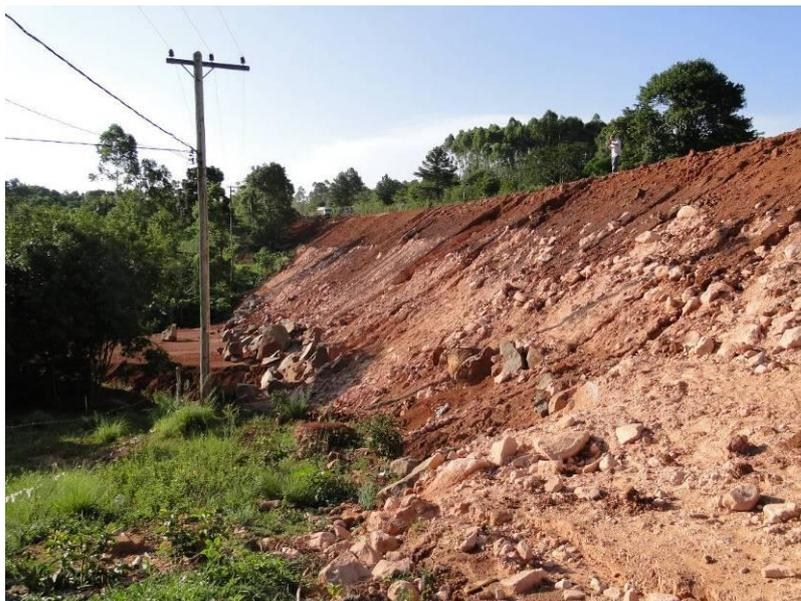
Figura 4.6. Vista geral de um aterro com problemas de ravinamento e sulcos.
