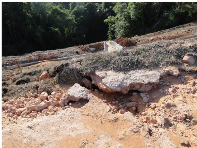
Figura 4.4. Foto do topo de um aterro com erosões importantes e infiltração de água.
