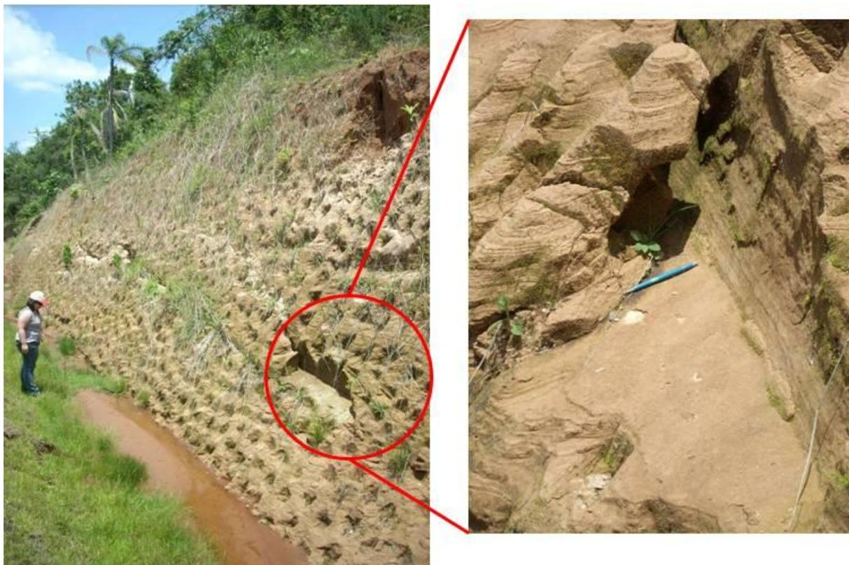
Figura 4.7. Vista geral de um corte com problemas de escorregamentos por estratificação.
