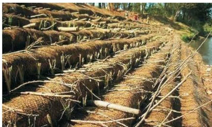
Figura 2.29. Revitalização da margem do rio utilizando solo envelopado e madeira com estacas vivas – Santa Luzia-MG, Rio das Velhas. Fonte: CBCN, 2010.
