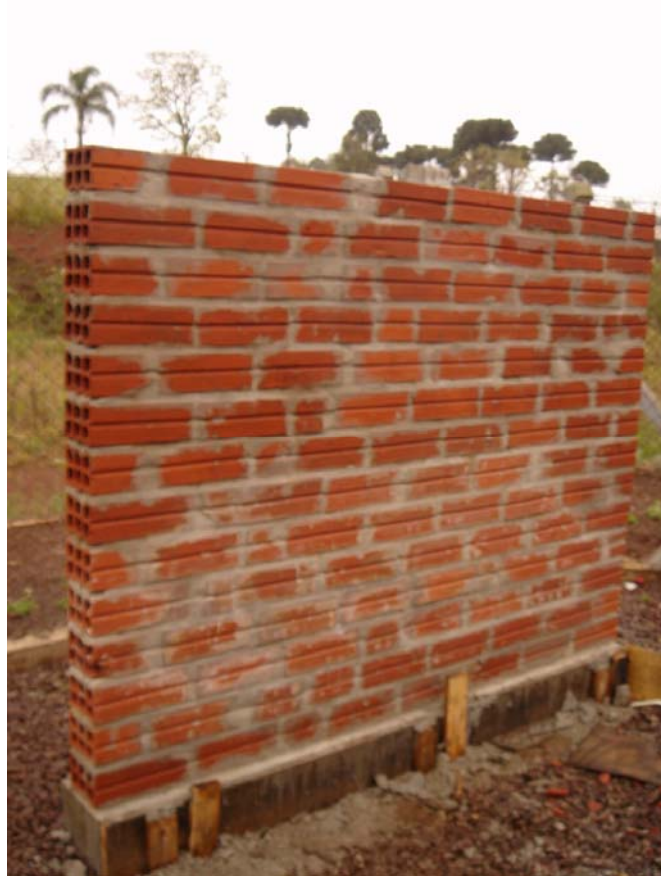
Figura 44: Parede experimental com blocos cerbamicos com areia de fundiçao.
