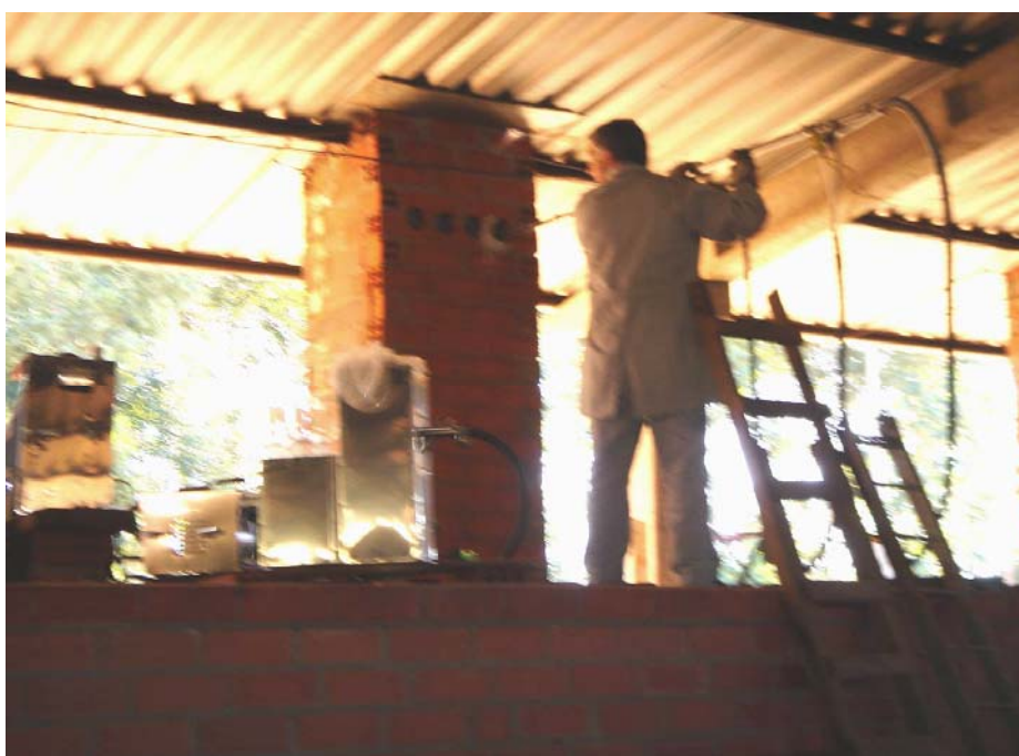
Figura 25: Chaminé de amostragem para a coleta das amostras de emissões gasosas na Cerâmica Getuliense.
