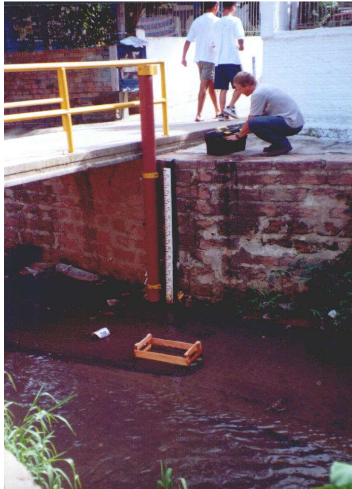
Figura 4.13 – Medidor de Nível Instalado no Ponto Amostral MN1 (Arroio Moinho)
