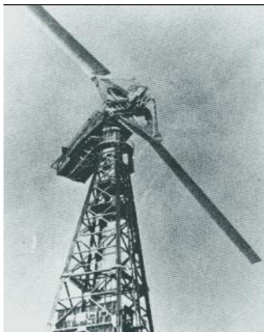
Figura 06: turbina tipo Smith-Putnam, 1.250 kVA, 53,3 m, USA, 1941(MOLLY,1990)
