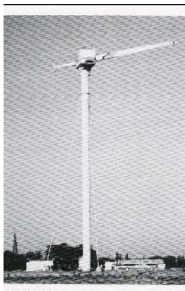
Figura 08: turbina MBB Monópteros, 380 kW, 48 m Durchmesser-Alemanha, 1982 (MOLLY, 1990)
