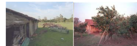
Galpão e casa da Dona Dila
