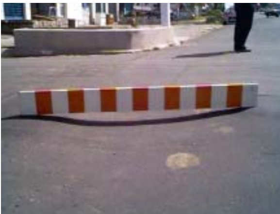
(a) Afundamento sem sollevamento lateral
