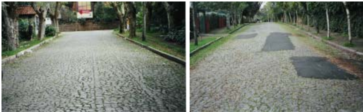
Figura 4.35 – Pavimentos de pedras irregulares em bom estado
