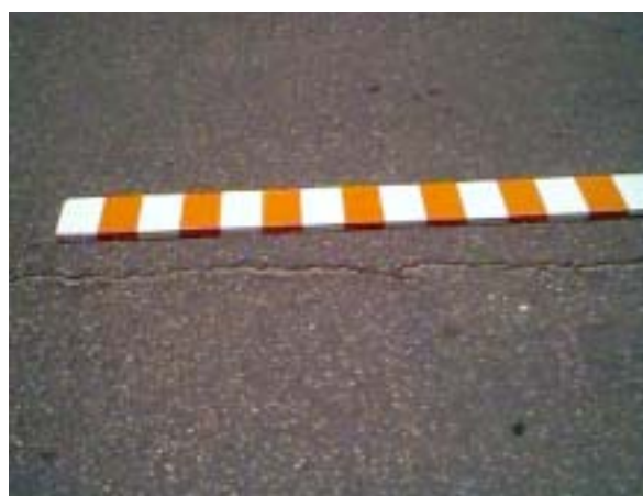
(b) Trinca isolada de retração ou reflexão
