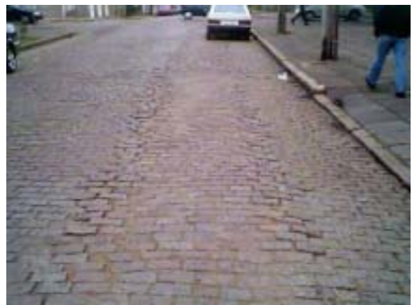
(b) Remendo de intervenção em rede subterrânea
