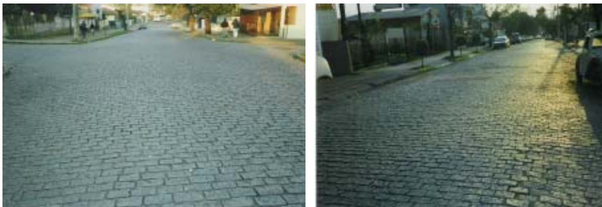
Figura 4.30 – Pavimentos de paralelepípedos em bom estado
