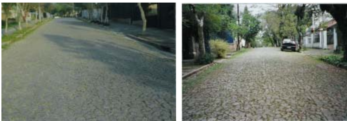
Figura 4.34 – Pavimentos de pedras irregulares em muito bom estado
