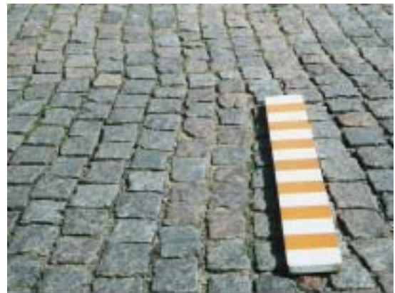
(b) Peças com desgaste ou polidas
