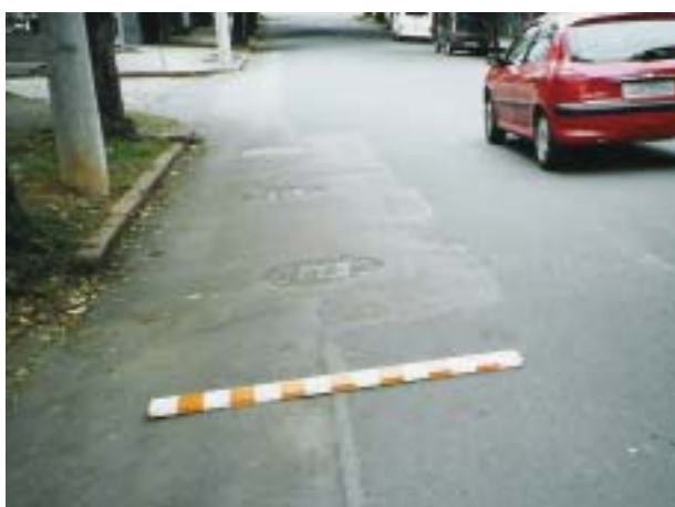
(a) Remendo de intervenção em rede subterrânea
