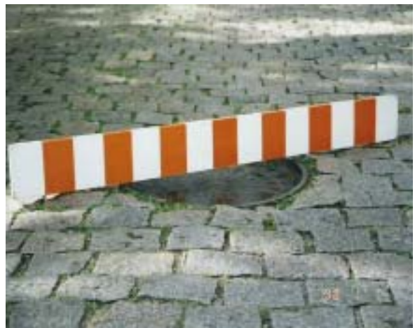
(b) Desnível de tampa de PV
