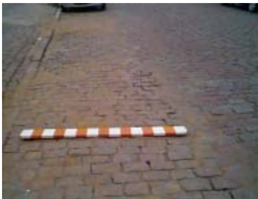
(a) Remendo de conservação padrão
