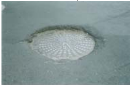
Remendo de Conservação Emergencial
