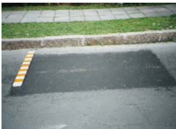
(a) Remendo de conservação padrão
