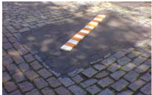
(b) Remendo regular com mistura asfáltica
