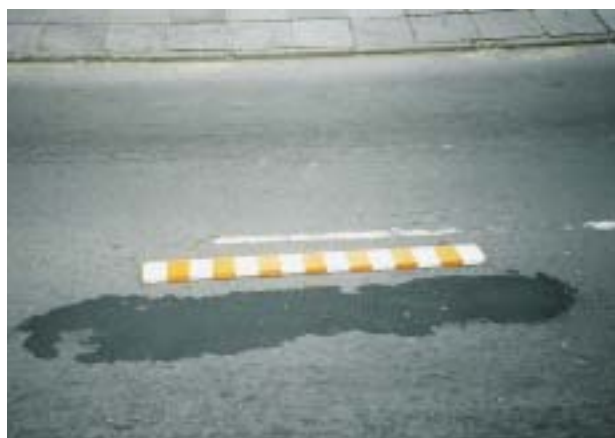
(b) Remendo de conservação emergencial
