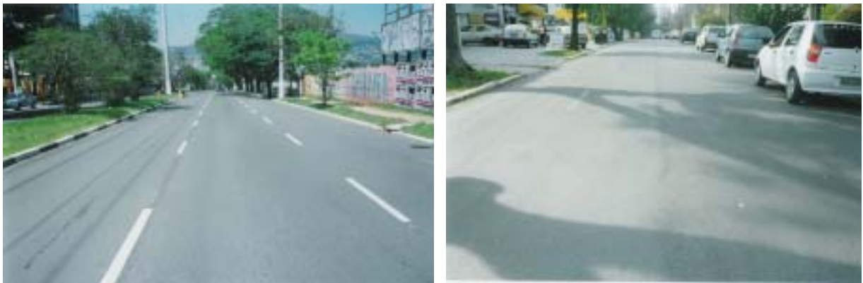
Figura 4.23 – Pavimentos com revestimento asfáltico em muito bom estado
