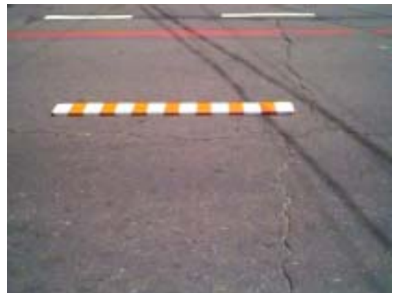
(b) Trincas interligadas de retração ou reflexão
