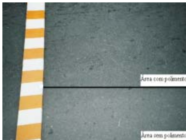
(a) Polimento de agregado
