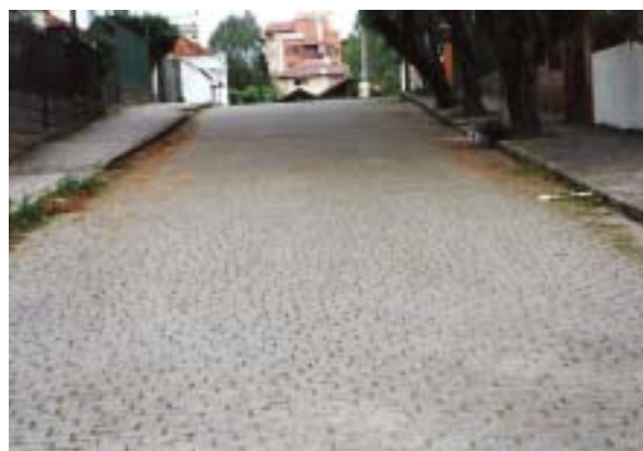
Figura 4.29 – Pavimentos de paralelepípedos em muito bom estado
