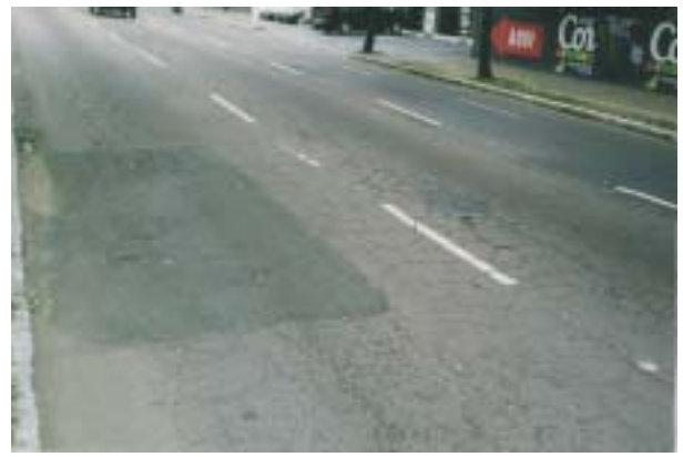
Figura 4.26 – Pavimentos com revestimento asfáltico em estado ruim
