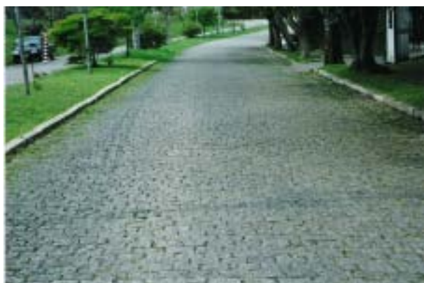
Figura 4.29 – Pavimentos de paralelepípedos em muito bom estado
