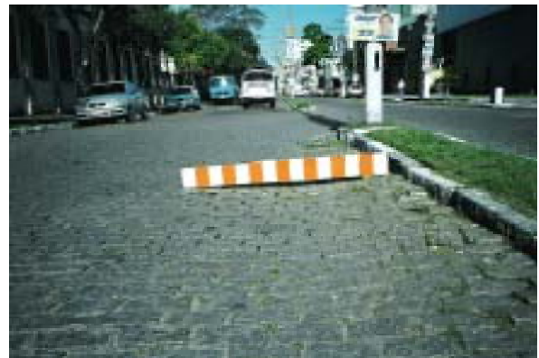
(b) Afundamento nas trilhas de roda com solevamento lateral
