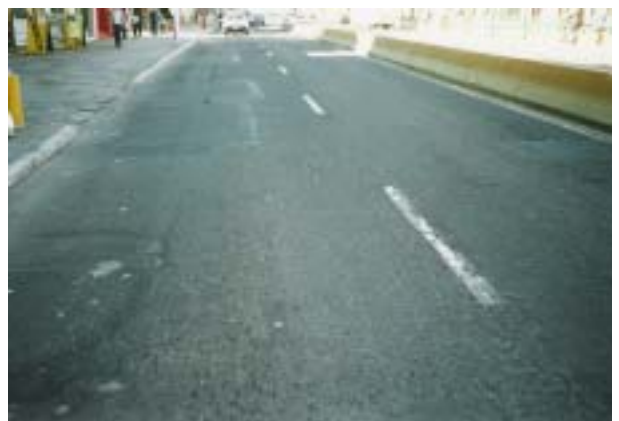
Figura 4.25 – Pavimentos com revestimento asfáltico em estado regular
