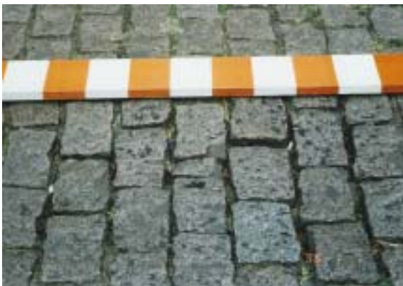
(a) Juntas sem preenchimento
