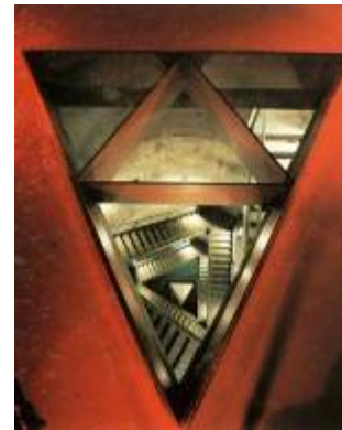
FIGURA 106: Interior da torre
