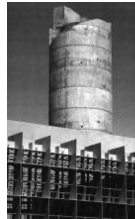
FIGURA 91: Vista exterior da grelha
