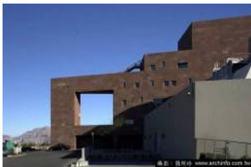
FIGURA 99: Prédio da Administração
