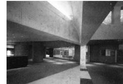
FIGURA 87: Interior hall de acesso
