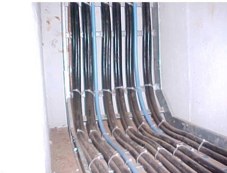
**Figura 17 – Cabos lançados e amarrados em um leito**
