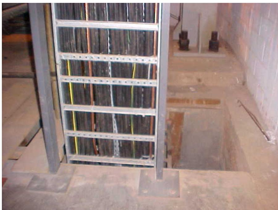
**Figura 7: Cabos lançados em leito (CGL)**
