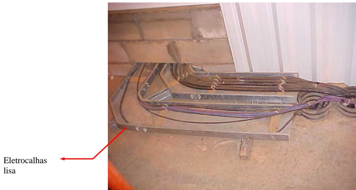
**Figura 11: Eletrocalha lisa instalada na linha CGL**
