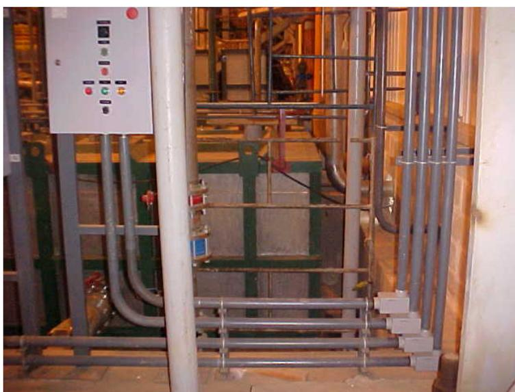
**Figura 14: Eletroduto de ferro fundido ligando um painel**
