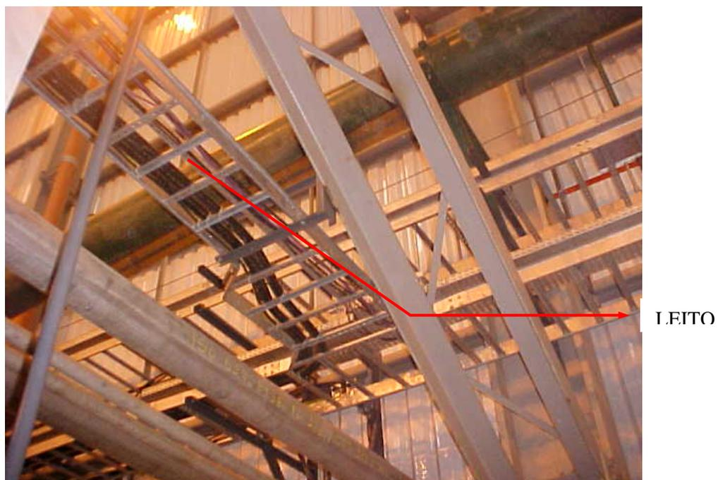
**Figura 6: Leito instalado no CGL**
