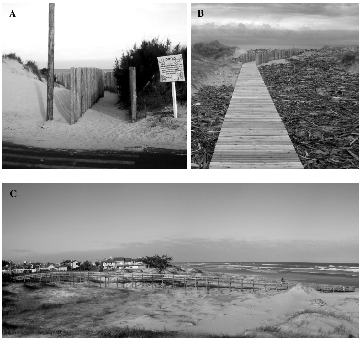
FIGURA Nº 7- Acessos de pedestres às praias em Xangri-lá e Osório. (A) Estacas de madeira enterradas diretamente na duna; (B) esteiras sobre a duna e (C) passarela. Fotografia: Luana Portz, (A) 13 de fevereiro de 2010; (B) 06 de janeiro de 2010; (C) 21 de dezembro de 2009
