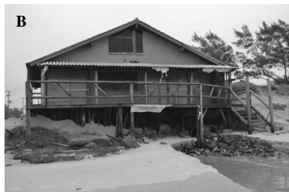
FIGURA Nº 9 - (A) Colocação da tubulação diretamente na face de praia. Este tipo de intervenção aumenta o risco de inundação e de erosão nas áreas adjacentes. (B) Deságue do sangradouro abaixo do quiosque. Fotografia: Rogério Manzolli (A) e (B) 29 de agosto de 2011.
