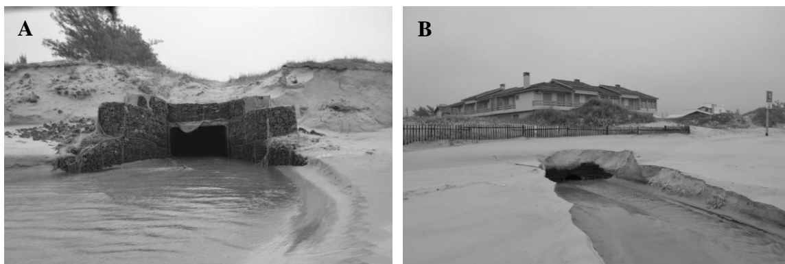
FIGURA Nº 10 - Passagem da tubulação por de baixo da duna frontal, tornando desta forma o sistema de dunas contínuo e mais estável. (A) Construção de galeria passando por baixo do sistema de dunas; (B) utilização de canos. Fotografia: Rogério Manzolli (A) e (B) 29 de agosto de 2011.
