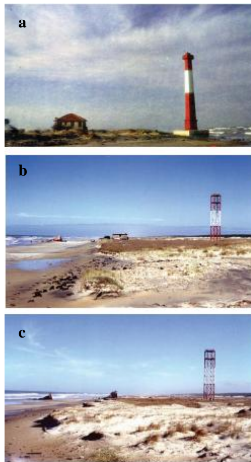
Figura 8 – Farol da conceição; (a) Vista para o norte em 1988; (b) vista para o sul do farol tombado e da nova estrutura do farol à direita, 1997 e (c) 1999, o qual se encontrava localizado ao longo de extenso segmento erosivo do litoral médio do estado. Fonte: Toldo Jr. et. al., 2006. Fotografias (a) Edgar e Liana Timm; (b) e (c) Toldo Jr. e Almeida.
