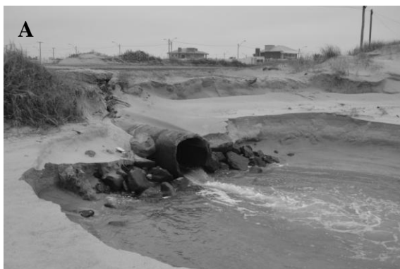
FIGURA Nº 9 - (A) Colocação da tubulação diretamente na face de praia. Este tipo de intervenção aumenta o risco de inundação e de erosão nas áreas adjacentes. (B) Deságue do sangradouro abaixo do quiosque. Fotografia: Rogério Manzolli (A) e (B) 29 de agosto de 2011.
