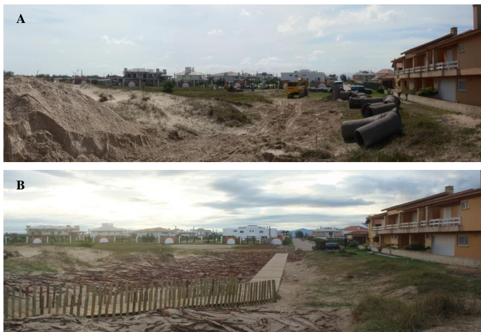
Figura 5 - Fotos da área de estudo; a) durante a abertura da duna para a colocação da tubulação de escoamento pluvial (dez de 2009) e, b) após a sua conclusão e colocação da esteira para acesso a praia (jan. de 2010).
