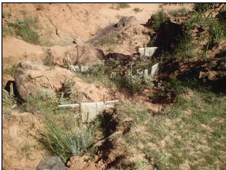
**Figura 34.** Paliçadas de bambu cobertas com manta de juta.
