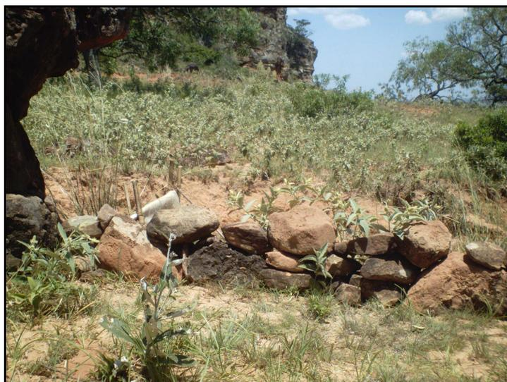
**Figura 44.** Construção da Barreira 3 composta por fragmentos de rocha e estabelecida na margem direita da ravina.
