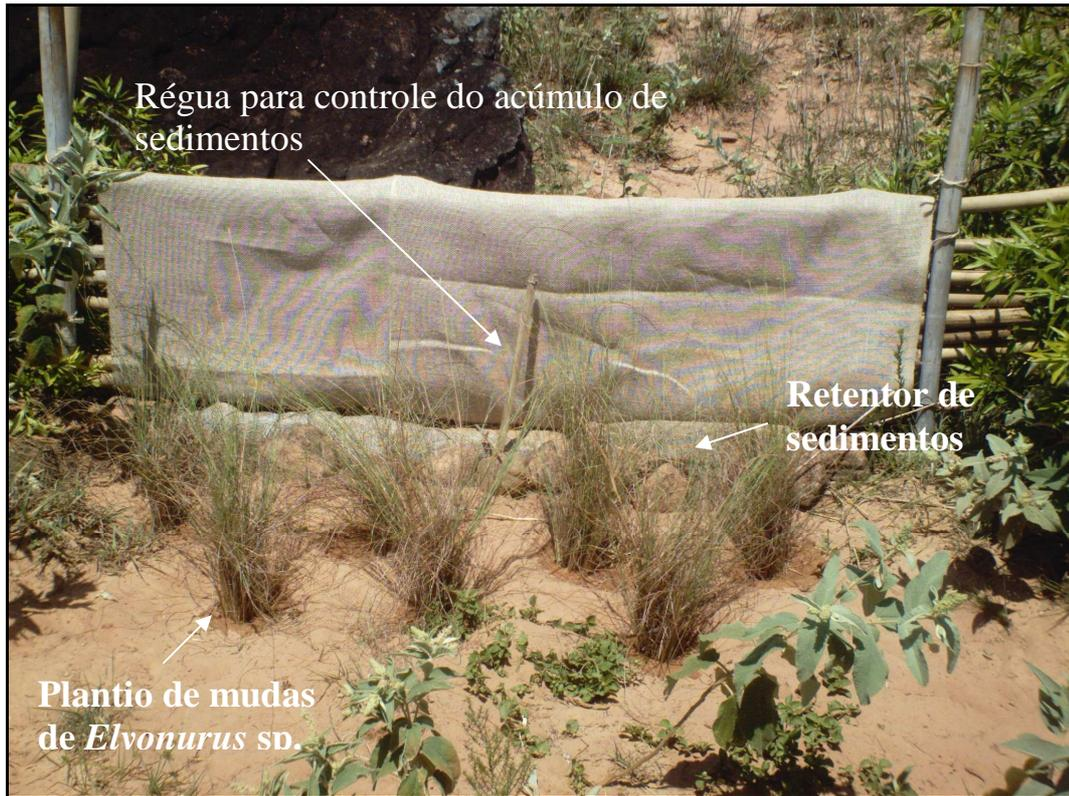
**Figura 40.** Conjunto paliçada nº 1 + biorretentores de sedimento + plantio de mudas de *Elyonurus* sp. Elaboração: Carmem Lucas Vieira (2012).
