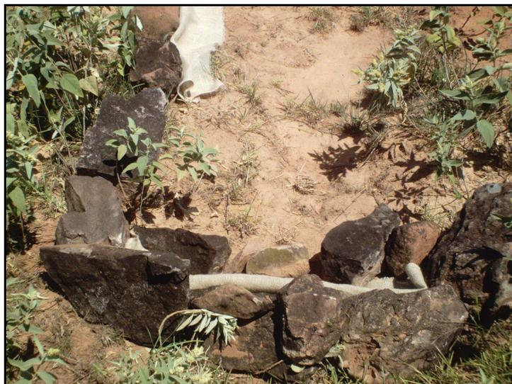
**Figura 43.** Construção da Barreira 2 composta por fragmentos de rocha com fibra de juta intercalada, e alocada na margem esquerda da ravina.
