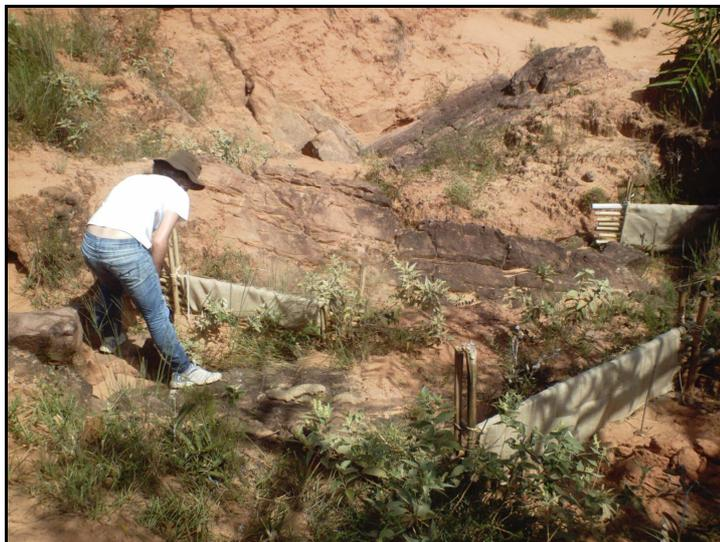
**Figura 31.** Enrocamento com três conjuntos de paliçadas.
