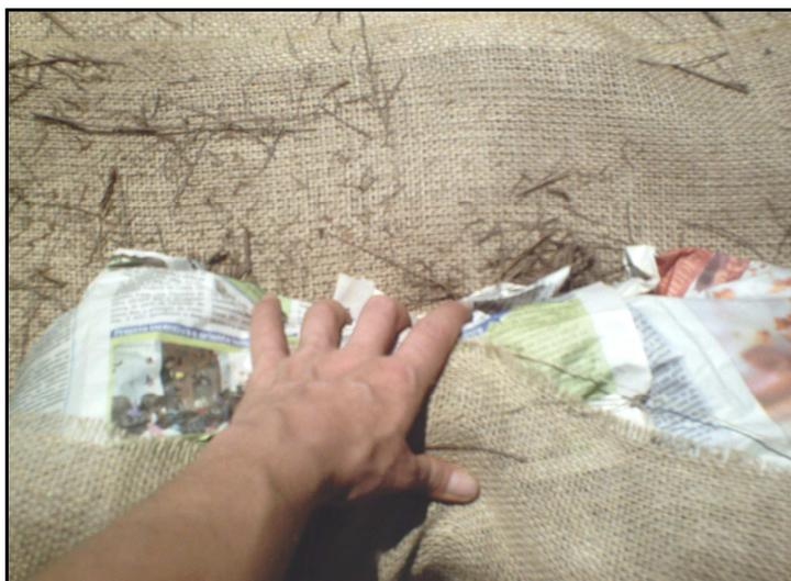
**Figura 37.** Embalagem do material na forma de pacotes cilíndricos para confecção de um biorretentor de sedimentos.
