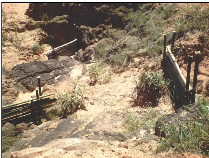
**Figura 32.** Conjuntos de paliçadas confeccionados com bambu.
