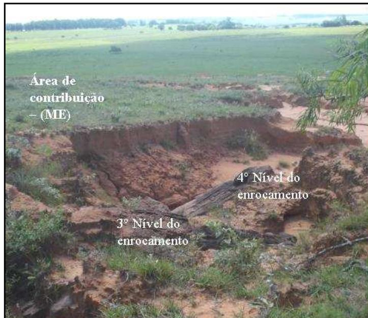
**Figura 22.** Vista montante-jusante da ravina, com dois níveis de enrocamento.
