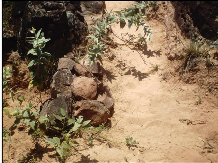
**Figura 42.** Construção da Barreira 1 composta por fragmentos de rocha com folhas de capim-limão (*Elyonurus* sp.) intercaladas, e alocada junto ao vértice da ravina.
