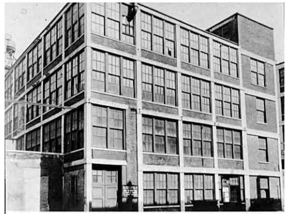
Fig. 140: Edifício Packard, A. Kahn, 1906. Estrutura em concreto armado e planta livre.
