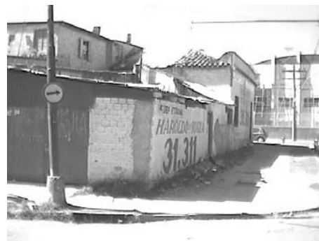
Figura 26: Esquina Avenida Zero Hora.
