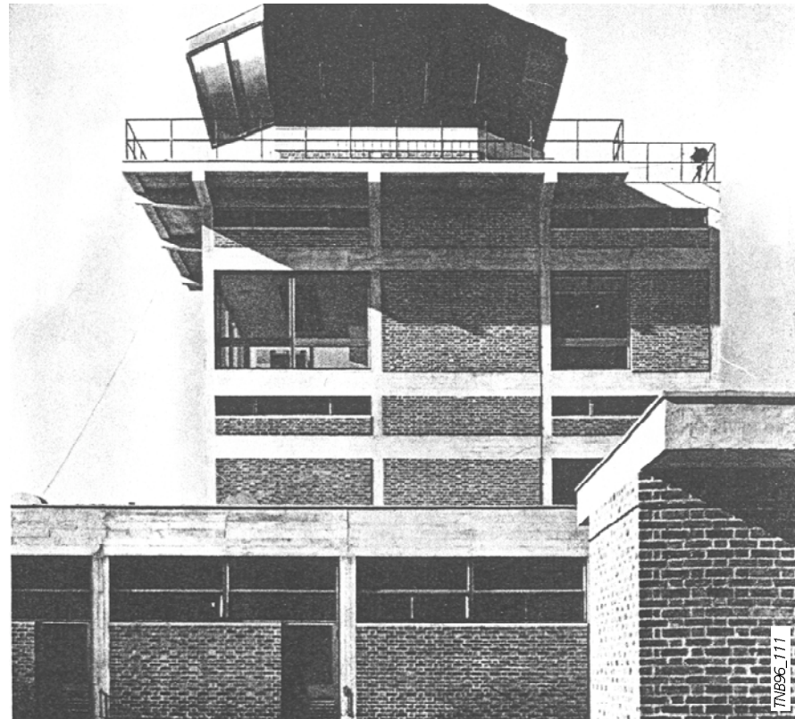
TORRE DE CONTROLE DO AEROPORTO DE GATWICK, 1957, YORKE, ROSEMBERG & MARDALL
