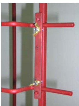
Figura 6 – Foto de detalhe da fixação
