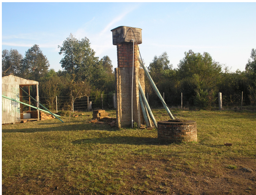
Figura 3: poço artesiano e antigo depósito da escola.
