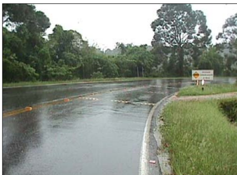
Foto 1 - km 90 - Início do trecho em estudo. Curva acentuada, onde foram colocados tachões sobre a pista (Guias Sonoras com Ranhuras Salientes) para redução de velocidade.
