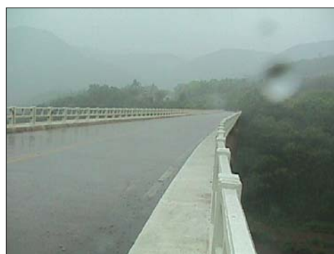
Foto 16 - km 109+500 - Ponte sobre o Rio das Antas, com 299,40 m.
