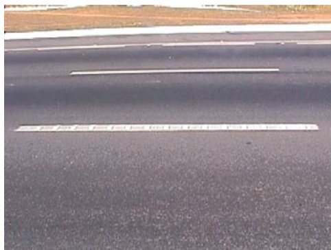
Figura 16 - Vista Geral do Megaline Profile Aplicado na Nova Via Dutra – SP. Fonte: (Foto obtida no local, outubro/2003)
