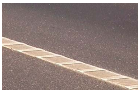
Figura 17 - Detalhe do Megaline Profile Aplicado na Nova Via Dutra – SP. Fonte: (Foto obtida no local, outubro/2003)
