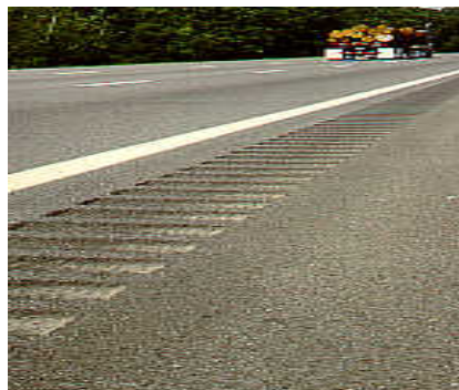
Figura 4 – Guias Sonoras no Acostamento em Rodovia em Nova Iorque. Fonte: (www.tfhrc.gov/focus/sept99/rumble.htm)
