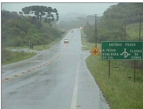
Foto 6 - km 96+700 - Acesso à Nova Roma do Sul/Nova Pádua e Acesso sec. à Flores da Cunha. Trecho de grande extensão em reta. Uso de Guias Sonoras com Ranhuras Salientes de Eixo.
