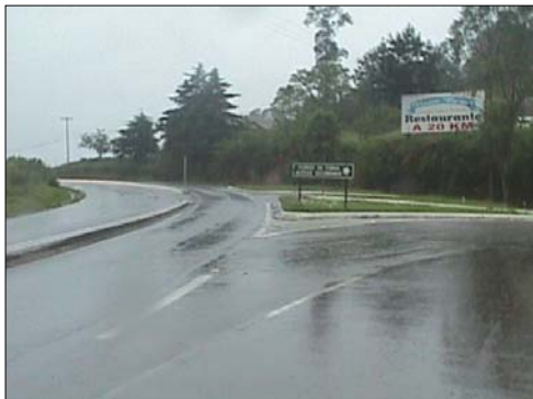
Foto 7 - km 99+700 - Trecho em curvas. Acesso à Flores da Cunha
