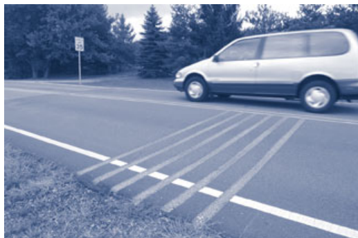
Figura 5 - Guias Sonoras de Pista. Fonte: ( www.dublin.oh.us/city/deptdev/engineer/rumblestrips.html )
