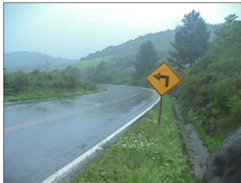
Foto 12 - km 103 - Local de curva acentuada. Percebe-se a falta do acostamento aqui e nos próximos km.
