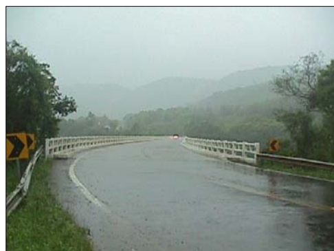
Foto 15 - km 109+500 - Início da Ponte sobre o Rio das Antas.
