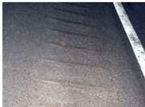
Figura 10 - Guias Sonoras com Ranhuras Cilíndricas. Fonte: ( www.eng.ucalgary.ca/CSCE-Students/transportation_safety.htm )
