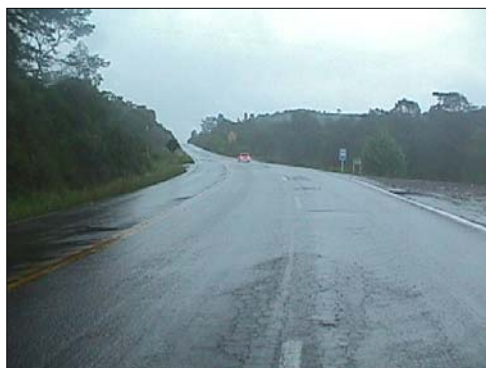
Foto 21 - km 126+200 - Acesso à Linha Camargo, trecho em terceira faixa.
