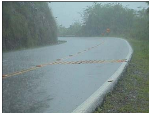
Foto 14 - km 104 - Trecho em curva acentuada, local de muito acidente, onde foram colocados tachões sobre a pista (Guias Sonoras de Pista com Ranhuras Salientes) para redução de
