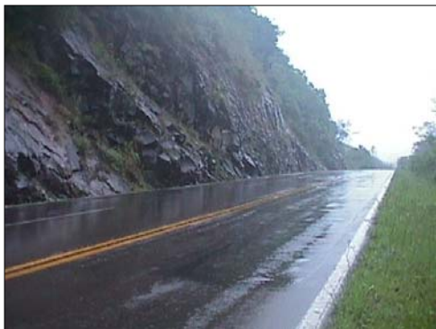
Foto 19 - km 112 - Detalhe dos cortes em rocha existentes ao longo do trecho estudado.
