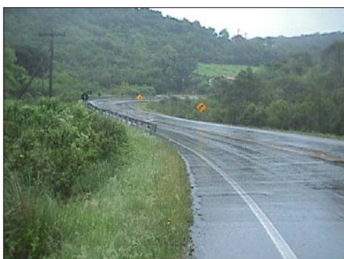
Foto 5 - km 94+600 - Curva em "S", em declive. Disp de segurança do tipo Defesa.
