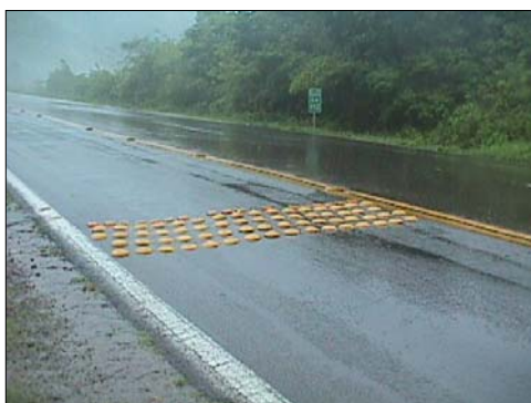
Foto 18 - km 112 - Guias Sonoras de Pista com Ranhuras Salientes para redução de velocidade, terceira faixa na pista I D
