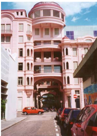
Figura 52 – Casa de Cultura Mário Quintana – vista externa
