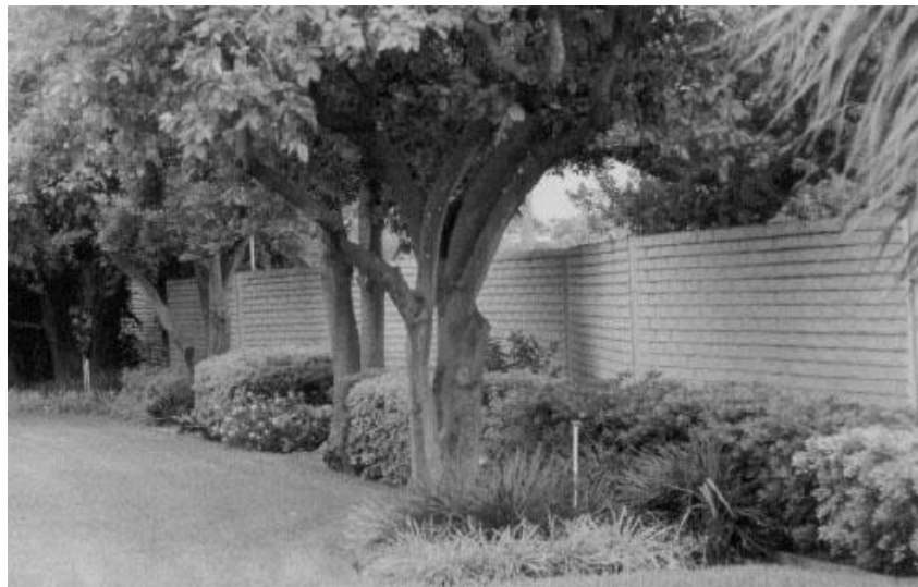
Figura 2.7: Barreira de tijolos de forma irregular.
