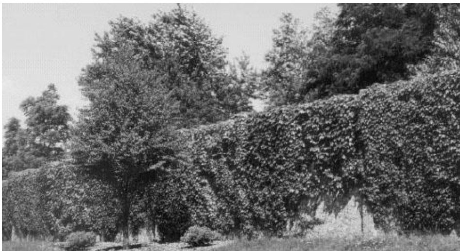
Figura 2.8: Muro de concreto com trepadeiras para evitar depredações.
