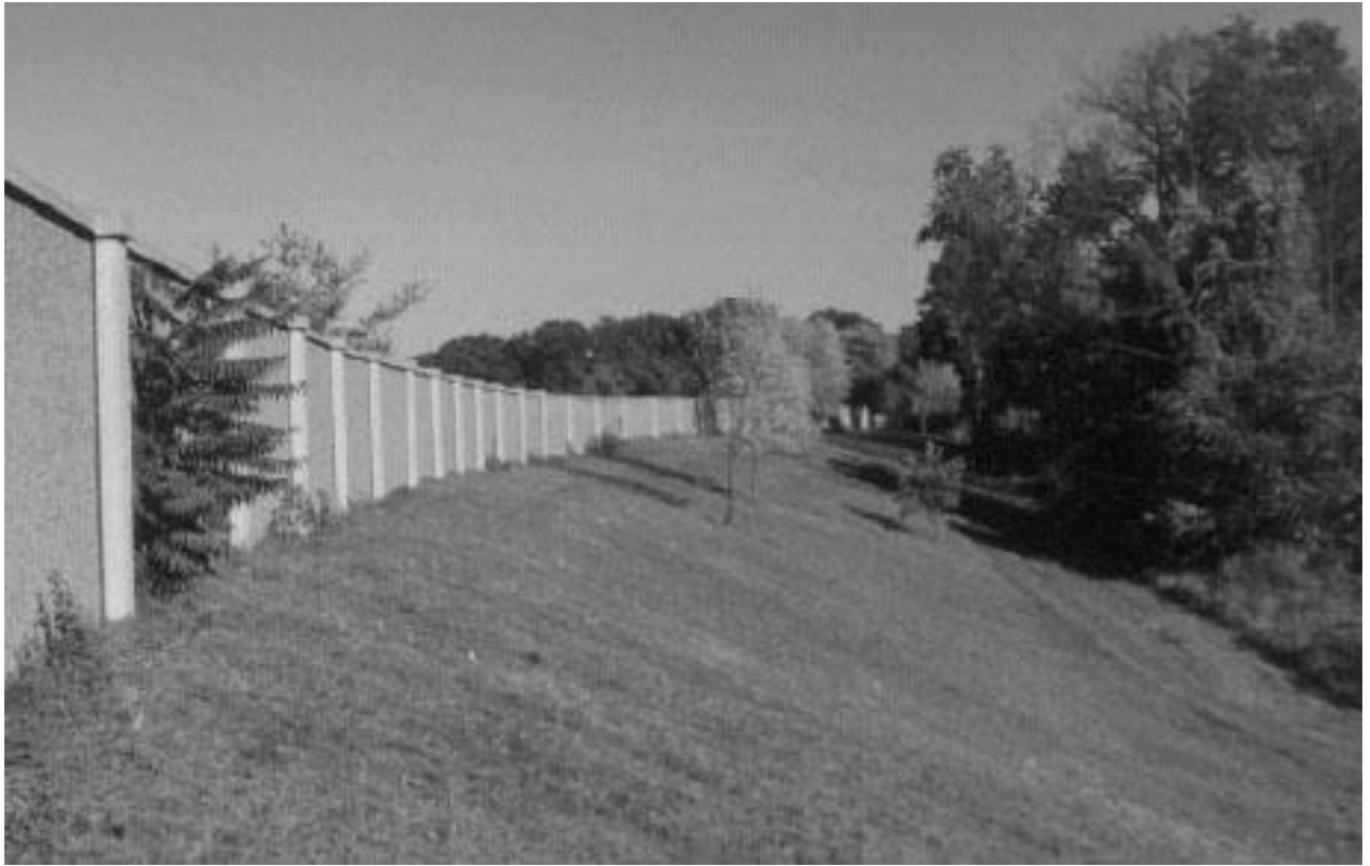
Figura 2.3: Barreira feita de um monte de terra e um muro de concreto.
