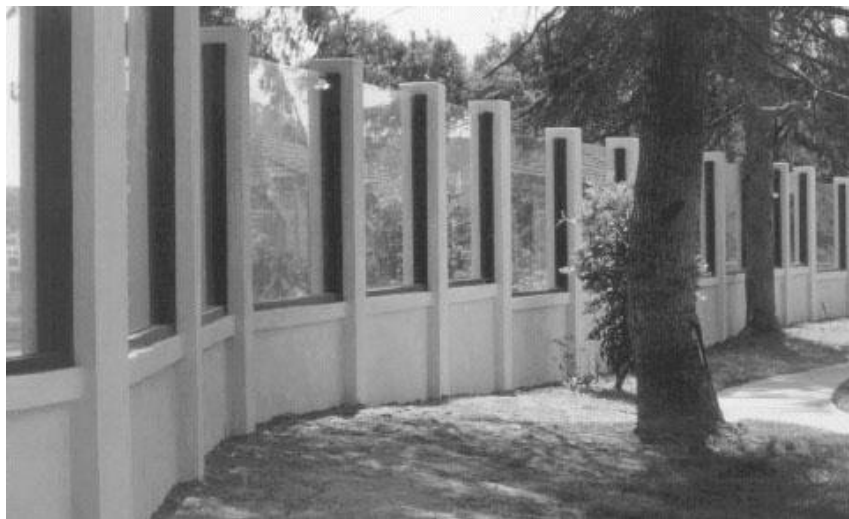
Figura 2.6: Barreira feita de acrílico para uma melhor visibilidade.
