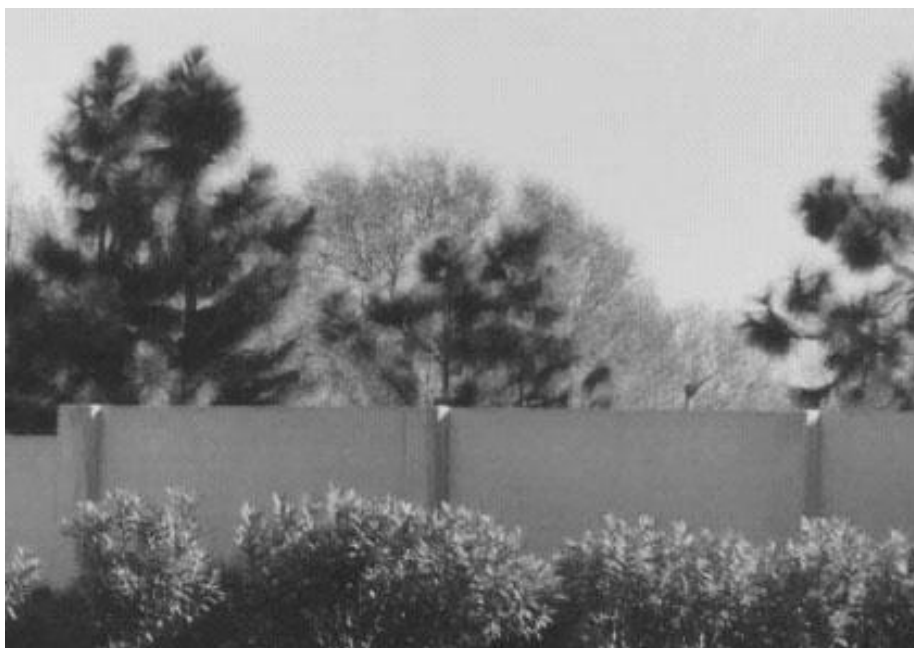
Figura 2.9: Barreira de concreto com vegetações impedindo o fácil acesso a depredações.
