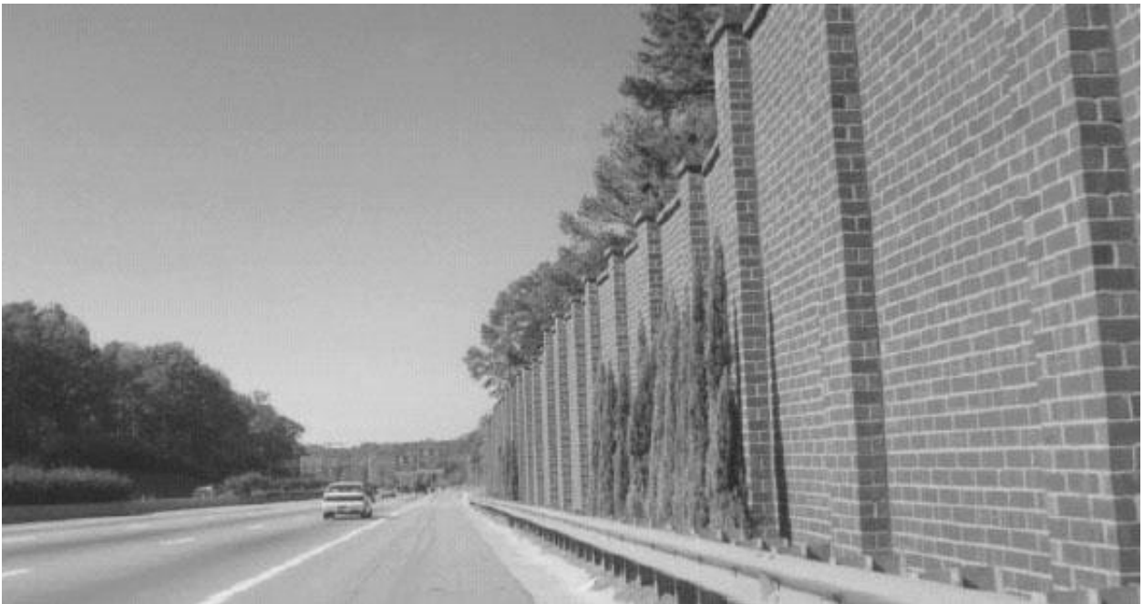
Figura 2.2: Barreira feita de um muro de tijolos.
