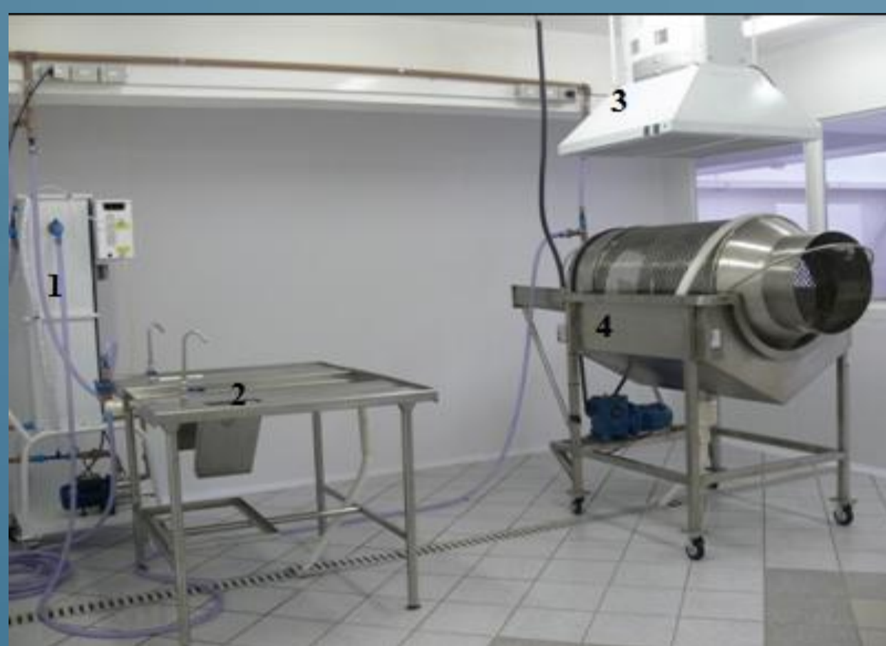
Figura 2: Laboratório de Aplicação de Ozônio em Alimentos – Eng. de Alimentos/UNISINOS (1) Ozonizador de água (2) Mesa de filetagem (3) Coifa (4) Lavador de pescado.
