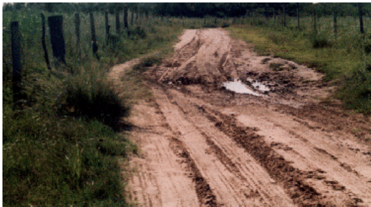
Foto da dificuldade de acesso, pelas más condições da estrada.
