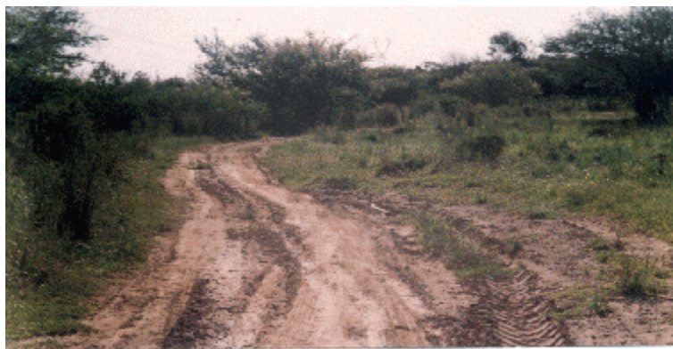
Foto da estrada de acesso aos lotes
