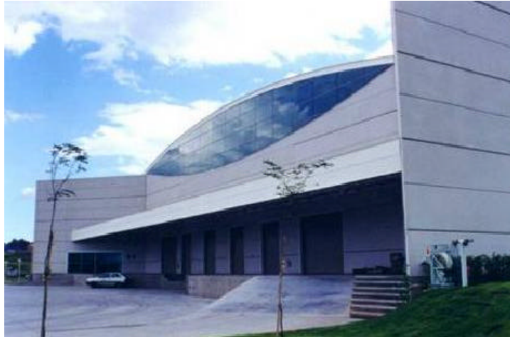
Figura 3.7 Edifício Flexotronics, Sorocaba-SP
