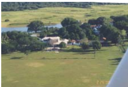
Figura 89 – Vista aérea da implantação da Pousada Fazenda Rio Negro. Fonte: Anderson Rocha
