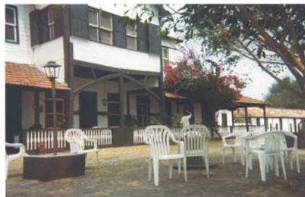
Figura 62 - Vista da área de encontro e lazer. Pousada Fazenda Rio Negro Fonte: Conservational International
