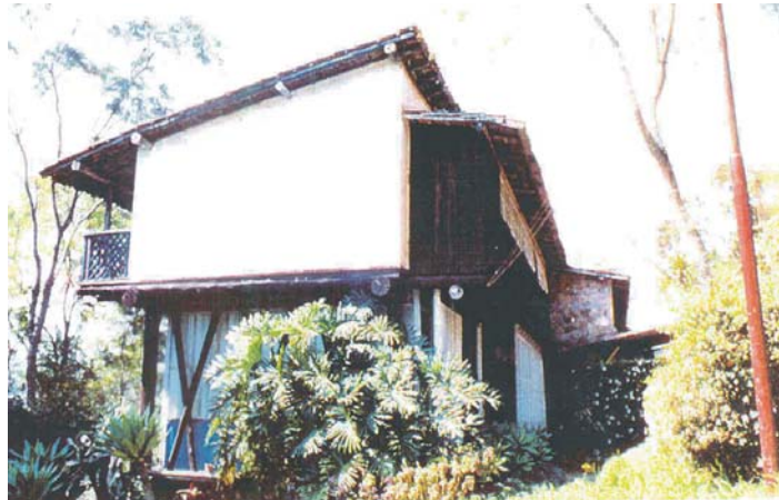
Figura 19 – Park Hotel – Nova Friburgo, Rio de Janeiro, 1940. Lúcio Costa. Fonte: Arq. Alberto de Souza.
