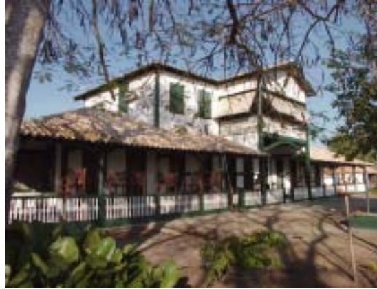
Figura 60 – Vista Casa sede da Pousada Fazenda Rio Negro. Fonte: Conservational International
