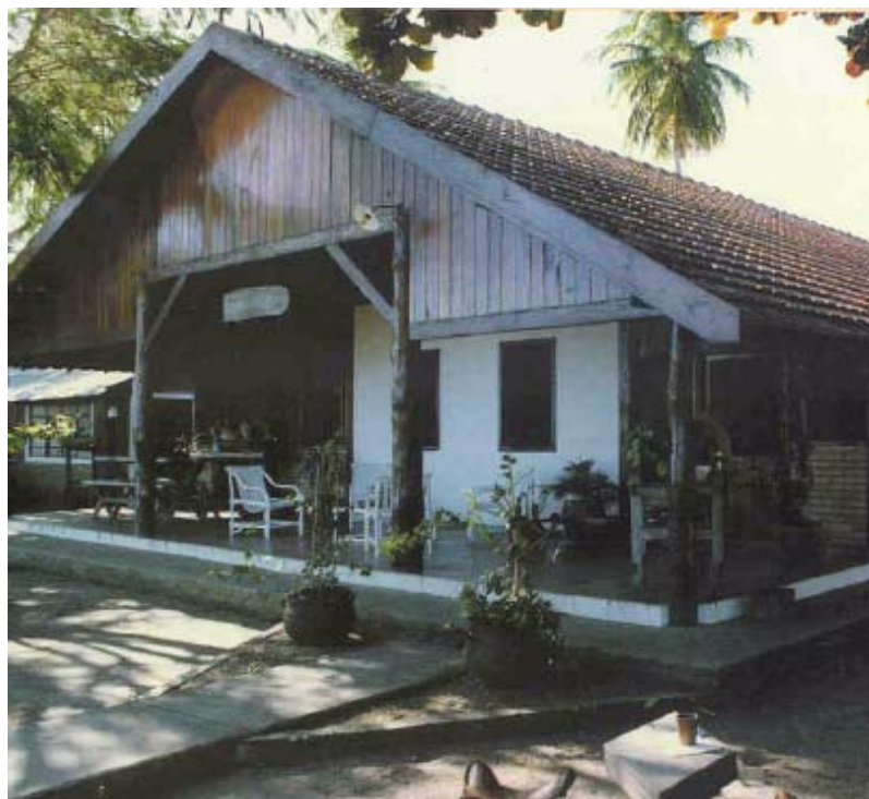
Figura 45 – Vista da Casa sede Pousada Aguapé. Fonte: Carlos Bodet
