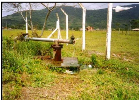
**Foto 02** – Vista lateral do poço tubular da CASAN –CIRO.
