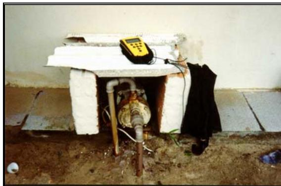
**Foto 04** –Típico poço do tipo ponteira amplamente difundido na região dos Ingleses
