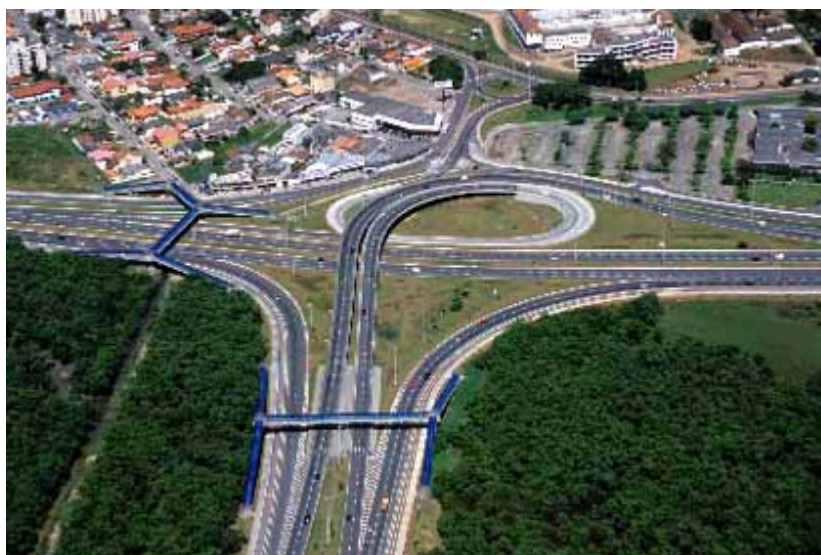
Figura 8.6. Fotografia mostrando a área do "Elevado do CIC", onde se deu a última agressão ao manguezal, na forma de aterro para a construção da obra e o alargamento da via.
