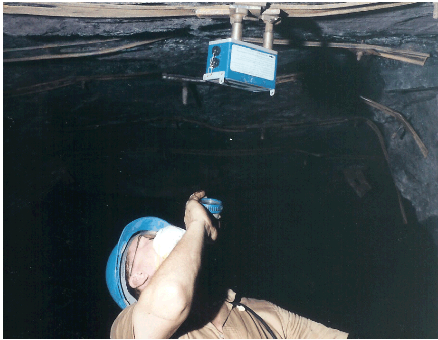
Figura 3.7 Sismógrafo Instantel Minimate™ DS-077 ancorado ao teto sendo ativado para monitorar um desmonte.
